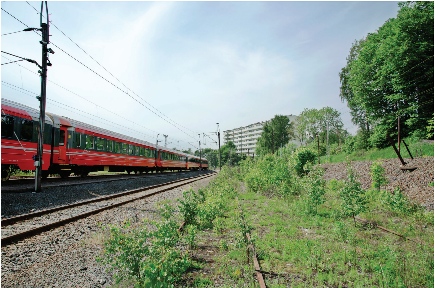
Jernbaneverket starter opprustningen av Kværnersporene (nede til høyre i bildet) høsten 2014. Foto: Hedda Nossen/Jernbaneverket
