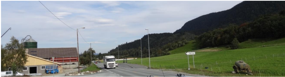
Figur 4-12 Foto av søndre del terminalområdet for 2B mellom dagens E6 ved Øya videregående og dagens Dovrebane (oppi lia)
