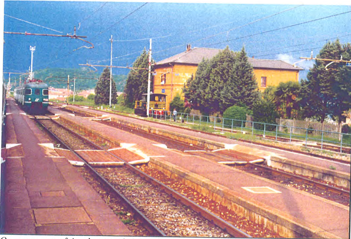
Overgang sett på jernbanestrekningen fra Tirano til Milano
