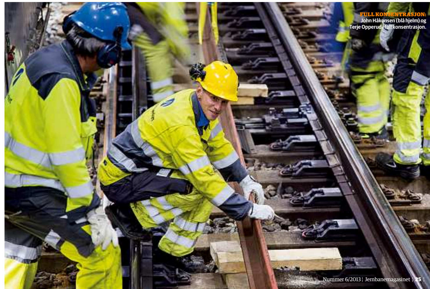
TAR TAK: Samtlige tar i et tak for å få på plass tunga inne i vedlikeholdstoget
