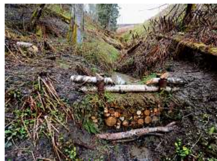
NATURMETODEN: Steinar Myrabø bruker grankvister mellom stokker av bjørk, osp og or i dam-området til å bygge kvistdammer.
