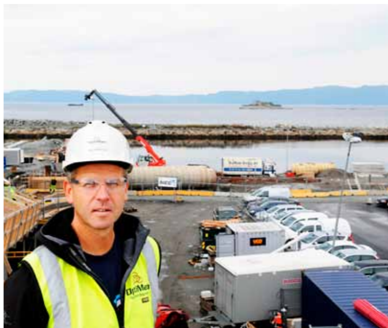
UT MOT HAVET: Prosjektleder Arne Hognestad skal ha gang- og sykkelbrua Sjøgangen ferdig til åpning 24. oktober. Fra brua er det fri utsikt til Munkholmen og svært kort gangvei til en rekke arbeidsplasser, hoteller, båtterminaler, badeland og pop- og rockmuseet Rockheim.
