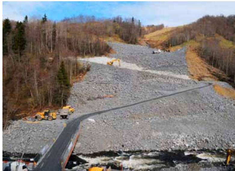
MYE MASSE: Et omfattende gjenoppbyggingsarbeid måtte til for å utbedre kjemperaset ved Snøan på Dovrebanen i vår.
