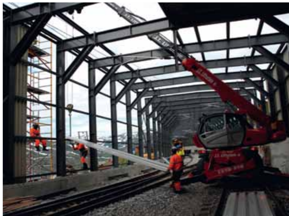
BRANNSIKKERT: Stasjonen og snøoverbygget som reiser seg på Hallingskeid, blir solide saker. Her skal det ikke brenne en gang til!
