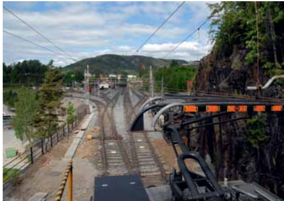
GJENOPPSTÅTT: Notodden stasjon ble fullstendig rasert etter et kraftig regnskyl i fjor sommer, men er nå gjenreist i sin fordums prakt.
