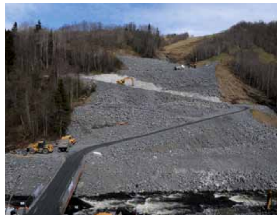
STORARBEID: Et lite jordras på jorden øverst i bildet utløste utglidningen i Soknedal. Reparasjonsarbeidene har tatt to måneder. På denne tiden er det flyttet på over 80 000 m 3 masse - nok til å dekke gressmatta på Ullevaal stadion med et 11 meter høyt berg.
