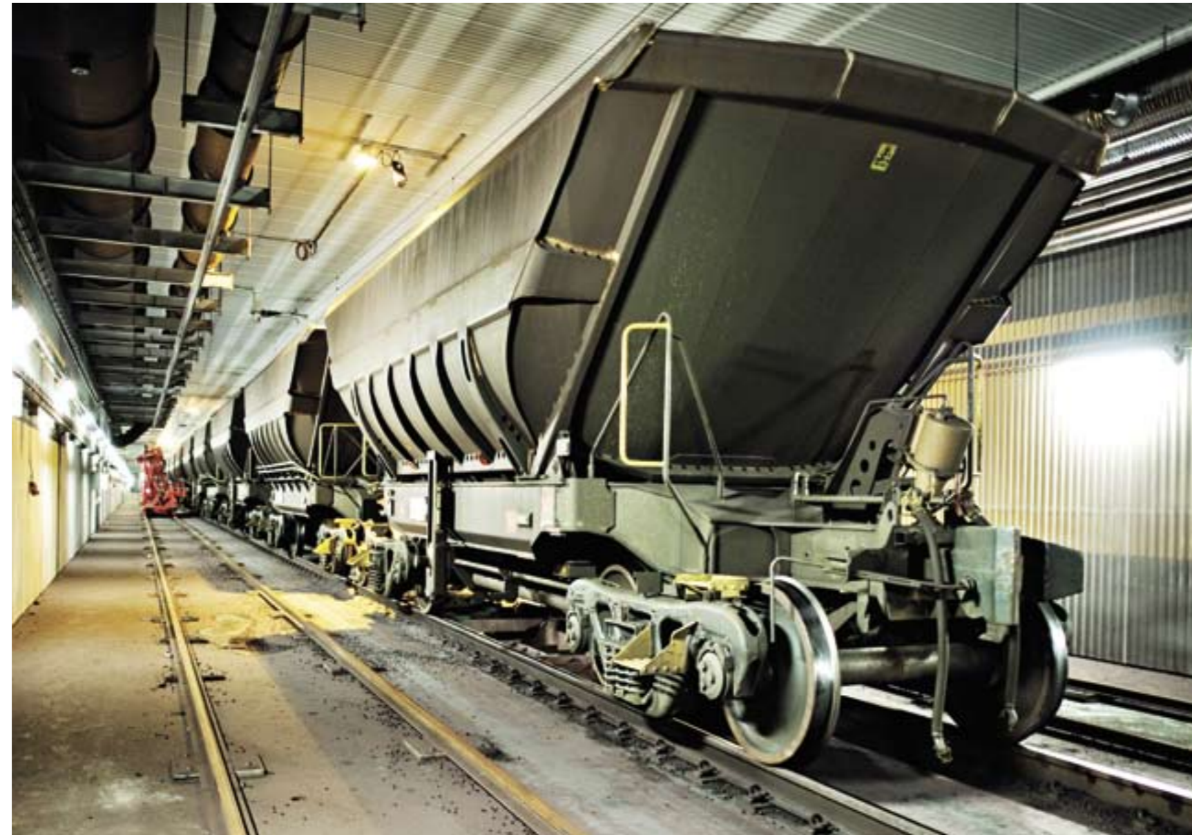
TØMMES: Malmen tømmes over 60 meter dype siloer, før den så går videre på transportbånd til havnen og lastes over i store lasteskip.
