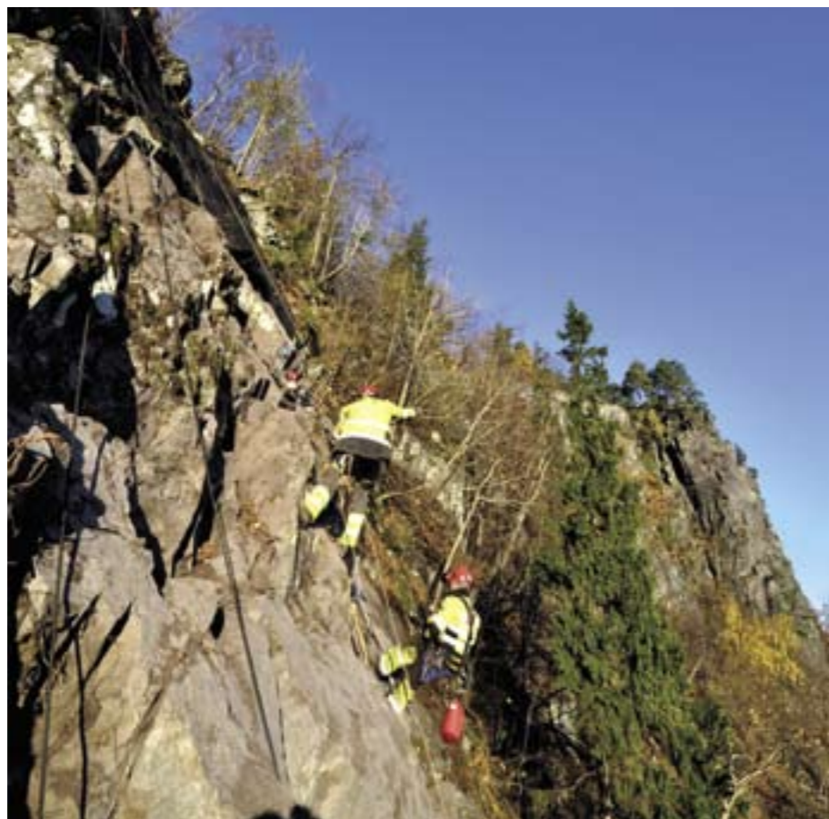
KREVENDE: Fjellet nord for Holmestrand renses for trær, røtter, jord og løse steinblokker. Deretter skal det sikres.
