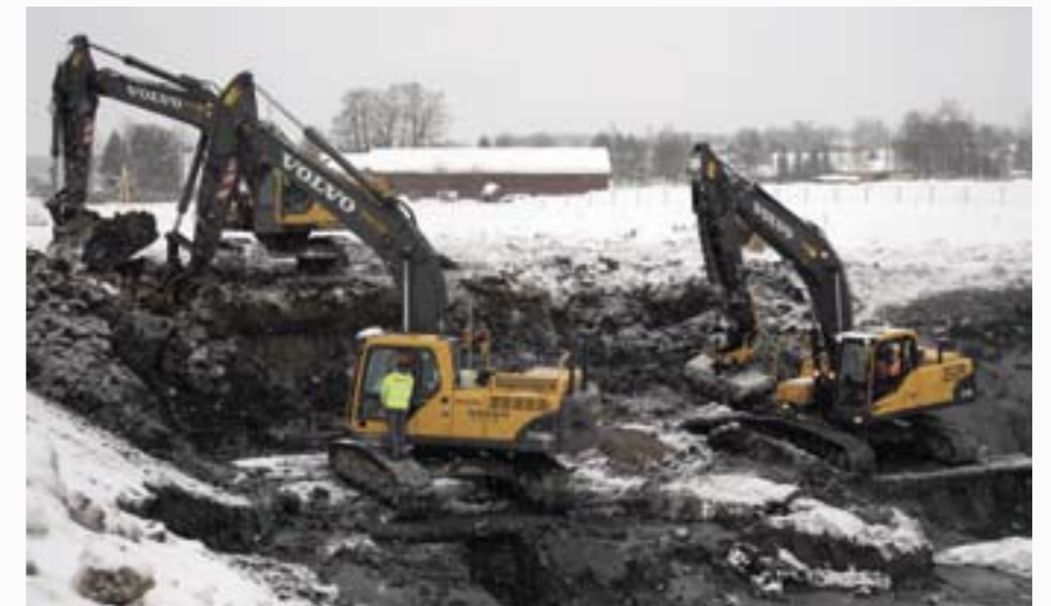
NEDSENKET BANE: Gjennom Barkåker skal banen gå nedsenket i forhold i terrenget og mye bløte masser må fjernes.
