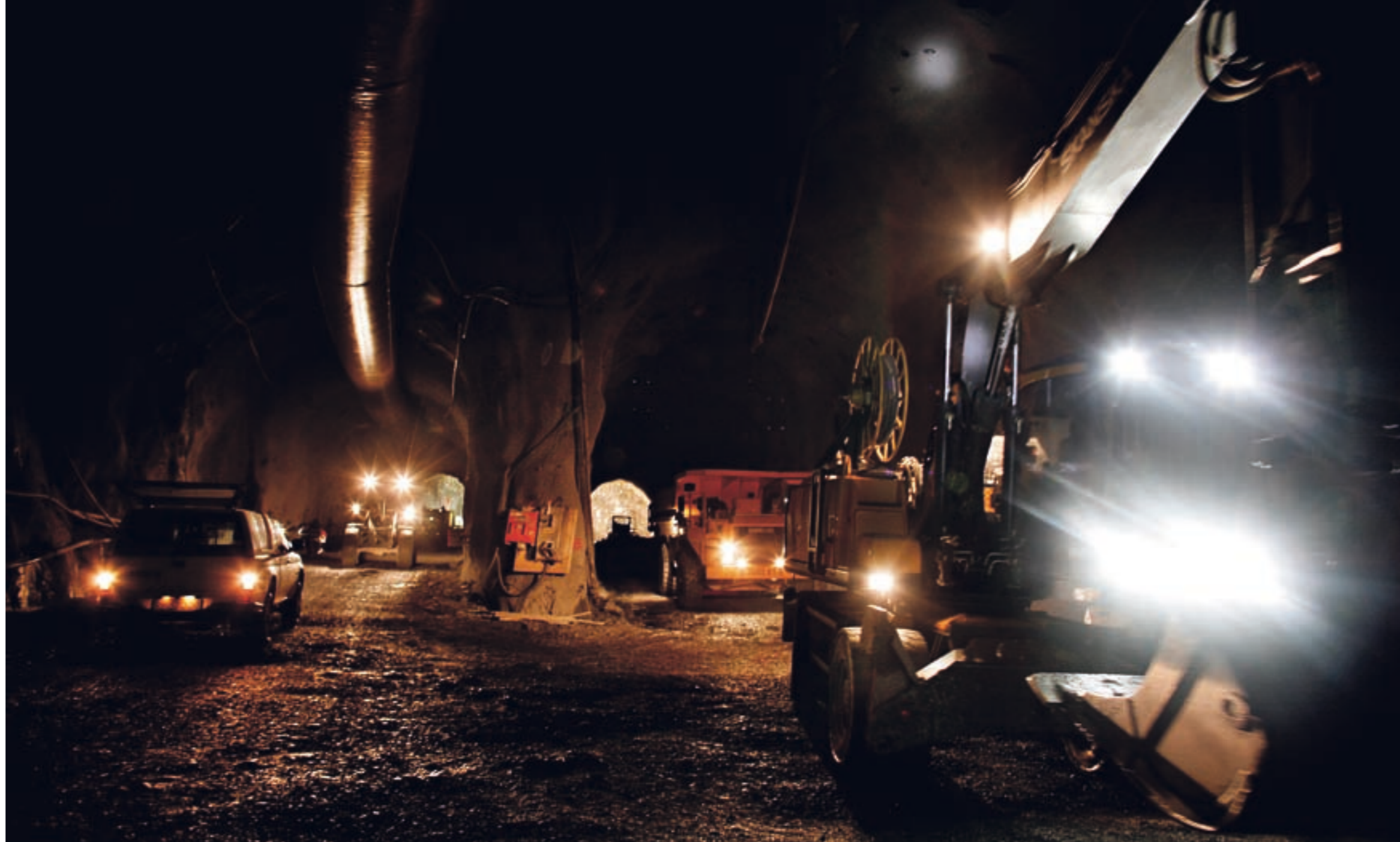
LANGE ARMER: Armene på boreriggen kan strekkes ut til å bli 12 meter lange, og det gjør at det blir enklere å sette inn sikringsbolter øverst i hengt eller taket av tunnelen.
