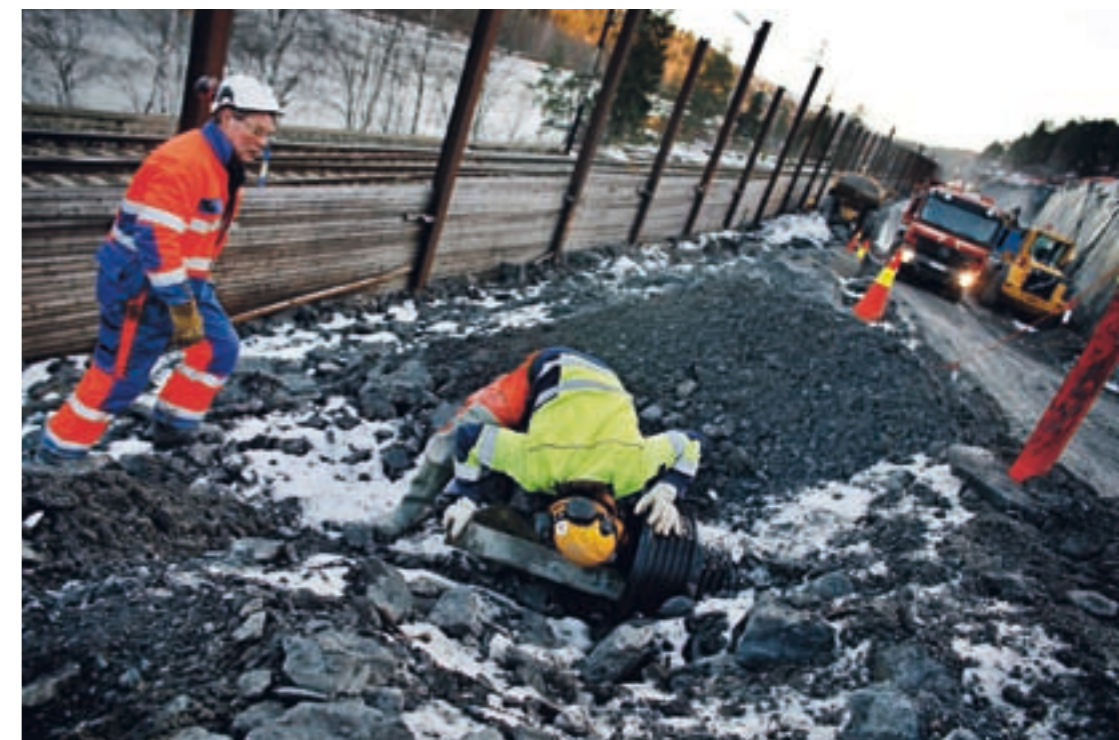
GRØFTELANGS: Tormod Løkken (til venstre) og Per Petterson holder på å legge ned en pumpeledning under anleggsveien.
