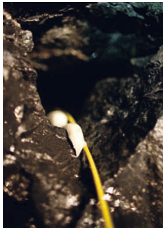
TYKTFLYTENDE: Sprengingsstoffet Slurrit er en tyktflytende masse som blir pumpet inn i borehullene med en slange.
