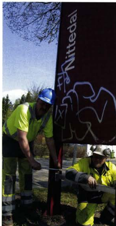
NOK Å GJØRE: Baneformann Jan Helge Sollie og fagarbeider Kjell Magnussen har nok å gjøre på Gjøvikbanen om dagen.
