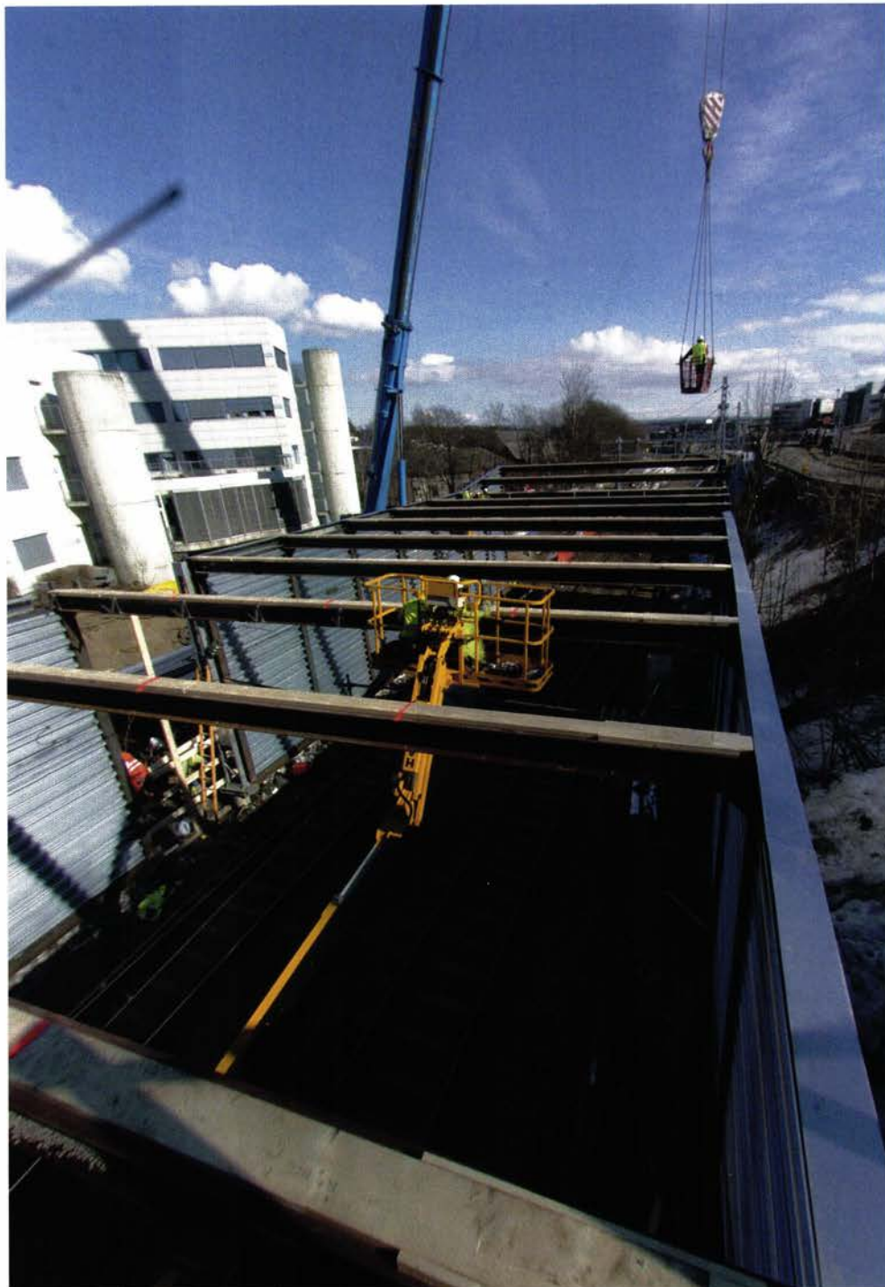
SIKKERHETSSKJERM: I løpet av den første togfrie helg i april ble det montert en sikkerhetsskjerm, slik at en ny Granfoss bru kan bygges uten at den kommer i konflikt med togtrafikken.
