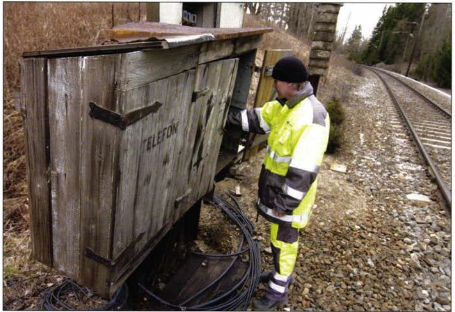
Gammelt: 63 prosent av signalanleggene på det norske jernbanenettet ble utviklet på 1950- og 1960-tallet. Her er oppsynsmann Ove-Erik Skovseth ved en gammel blokktelefonboks på Kongsvingerbanen som huser NSI63 signalanlegg.
