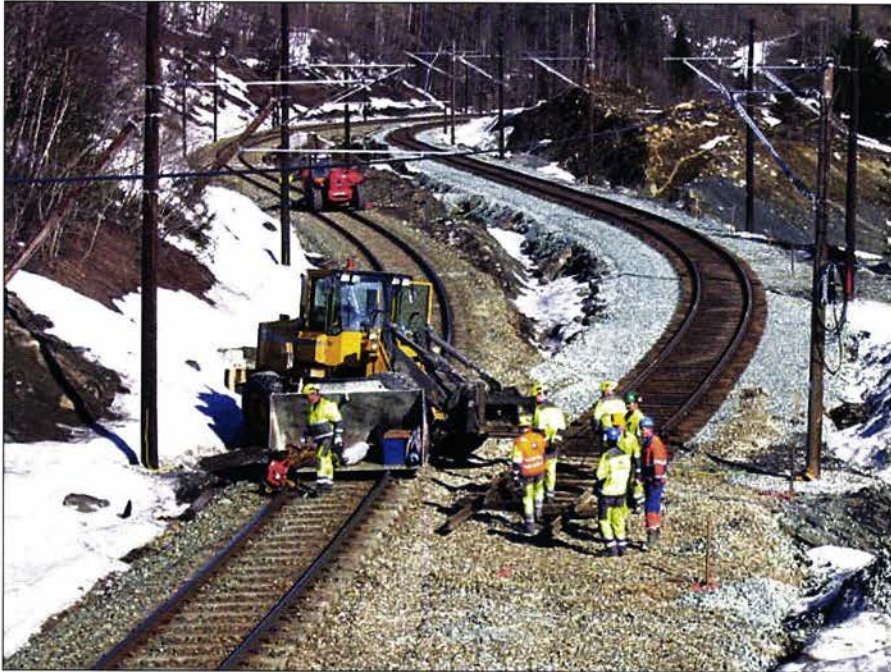
Like før: Her er det like før hovedsporets skinnegang bakeses over til det midlertidige sporet til høyre. (Foto: Erling Sporstøl.)
