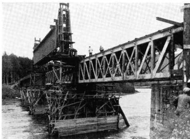
Fig. 20. Nytt spenn senkes ned.
