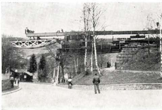
Fig. 6. Gammelt midtspenn tas opp.
