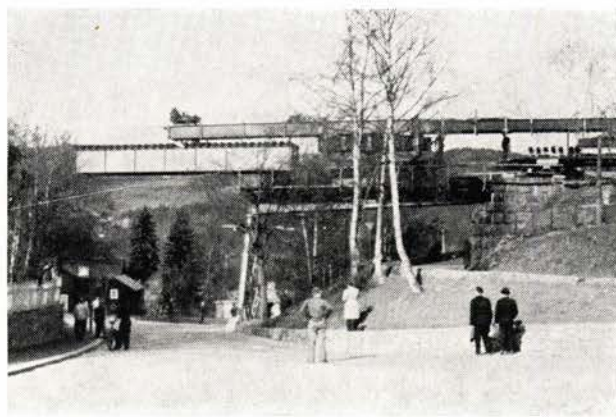
Fig. 7. Nytt midtspenn plasseres.
