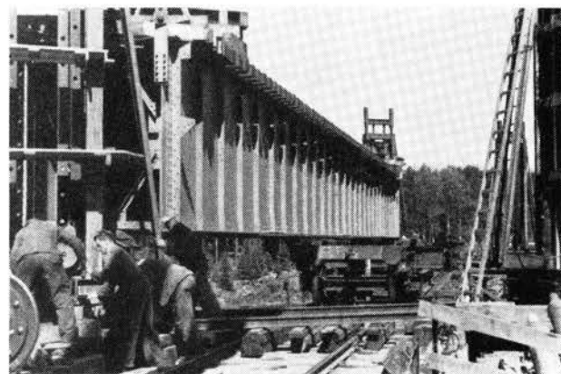
Fig. 19. Nytt spenn skyves ut på utskyvningsstillas.
