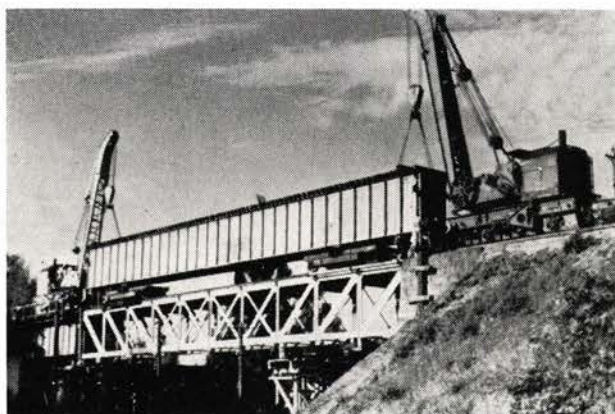
Fig. 1. Bru over Moelven. Nytt spenn hukes med kranene.
