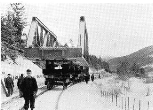
Fig. 4. Fremkjøring av nytt spenn til bru over Frya.
