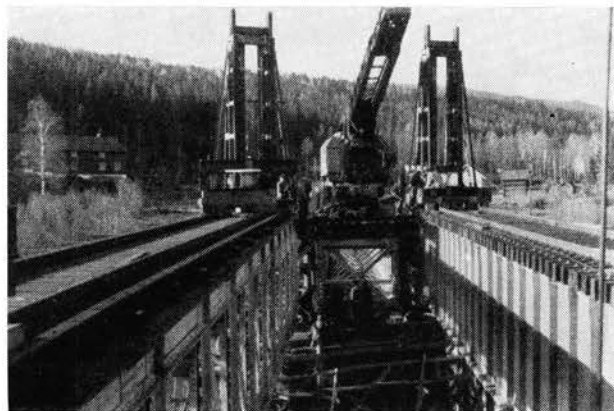
Fig. 21. Gammelt spenn skyves ut og nytt spenn inn.
