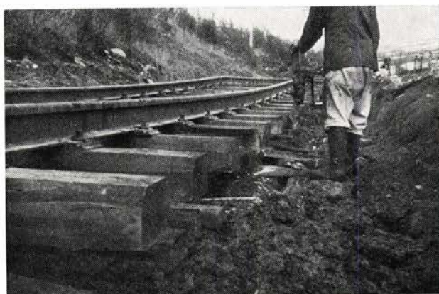
Fig. 10. Laustorv stemples i eventuelle åpninger mellom ballene og skinnelenken understøttes.
