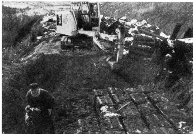
Fig. 7. En del av trauret er ferdig, og etter hvert som gravingsarbeidet går fram, legges torvbuntene på plass. Gravingsarbeidet nærmer seg slutten.
