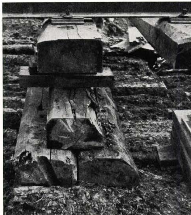
Fig. 11. Man ser hvordan skinnelenken understøttes. De øverste justeringsklossene fjernes etter at grusen er kjørt på, men de gamle svillene blir liggende. På en 15 meters skinnelenke har man vanligvis 4 understøttelsespunkter.
