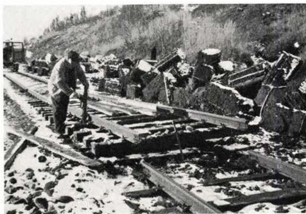
Fig. 2. Nattoget fra Trondheim til Saltdal har passert, og masseskiftingen kan begynne. Laskene skrues av skinnelenken (15 m). Skinnelenken jekkes opp for å få fri skinnegangsenden den skal skyves inn på.
