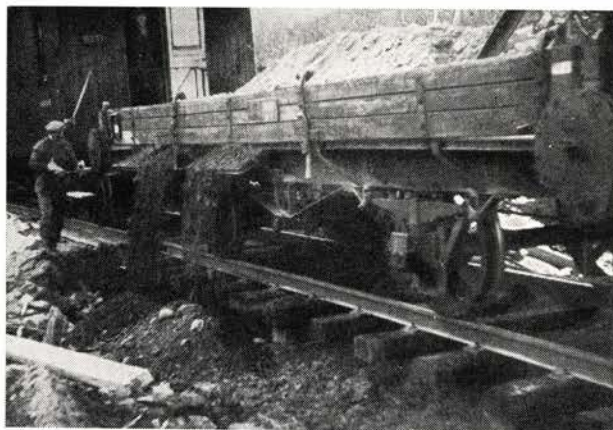
Fig. 14. Ms-vognene kommer med grustipp og tømmes.
