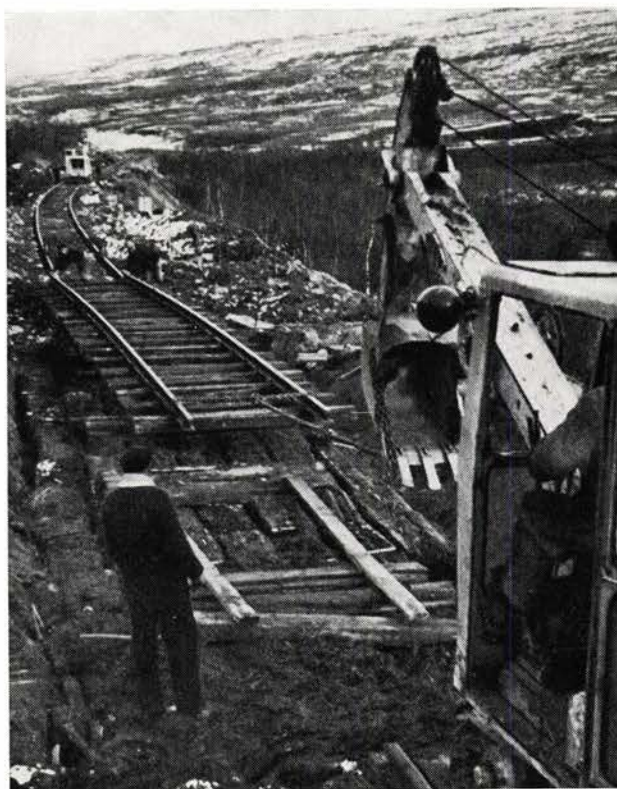
Fig. 9. Gravemaskinen trekker skinnelenken på plass.
