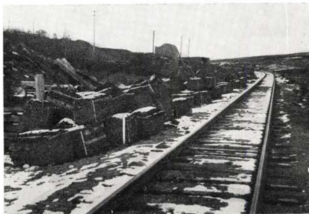
Fig. 1. Torvbuntene kommer fra Stargrassmyra torvfabrikk, Jørstad. De kjøres ut sammen med grusen og lastes av foran de daglige masseskiftingsstedene.
