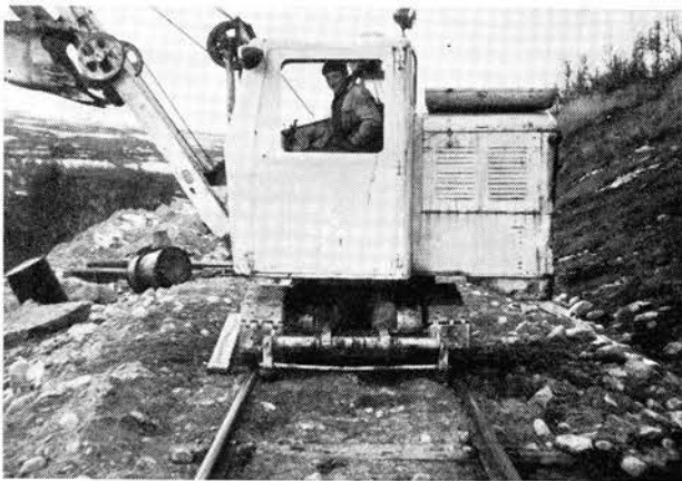
Fig. 4. Gravemaskinen er kjørt inn på sporet fra henstillingsplassen og er på tur til masseskiftingsstedet.
