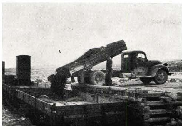
Fig. 13. Tømming av grusen fra bilen i Ms-vogner. Mannen midt på bildet plukker ut de største steinene av grusen og besørger fringen av vognene til rampen. Man benytter ikke lokomotiv mens lastingen pågår.
