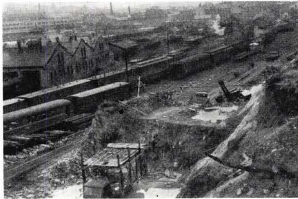
Siste rest av skjæring II.
