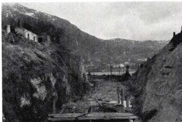
Gjennomskjæring bak tunnelen. Merk restene av sykehuset t. v.
