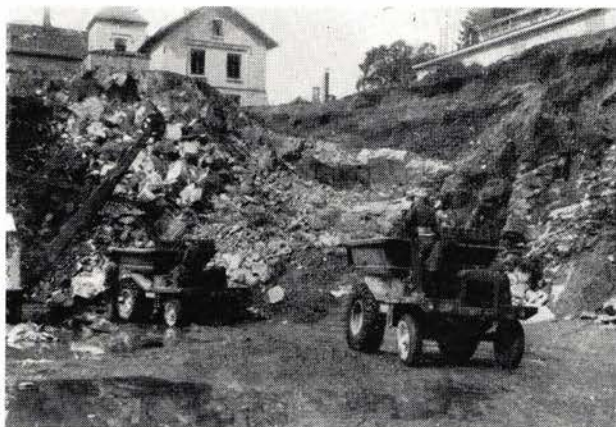
Dumpere i arbeide foran sykehuset.
