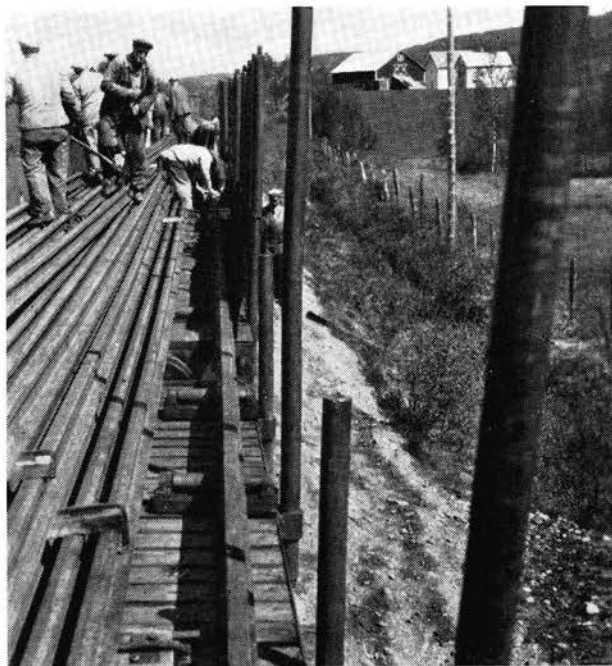
Fig. 8. Her sees ruller på vogn gulvet med skinnelast i 3 høyder.
