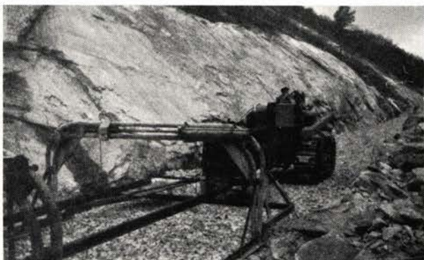
Fig. 11. Apparatets forende. Bjelkene er her senket. Man ser bulldozeren og kompressoren som forsyner stempene med luft.
