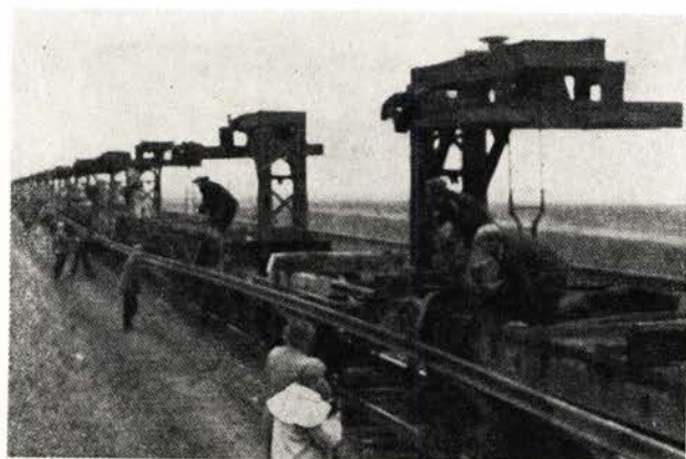
Fig. 6. Avlastning av 293 m langskinner til en 7 km lang strekning ved S. N. C. F.'s Region du Nord.
