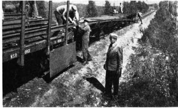
Fig. 5. Påsetting av lasker og 2 skruer.
