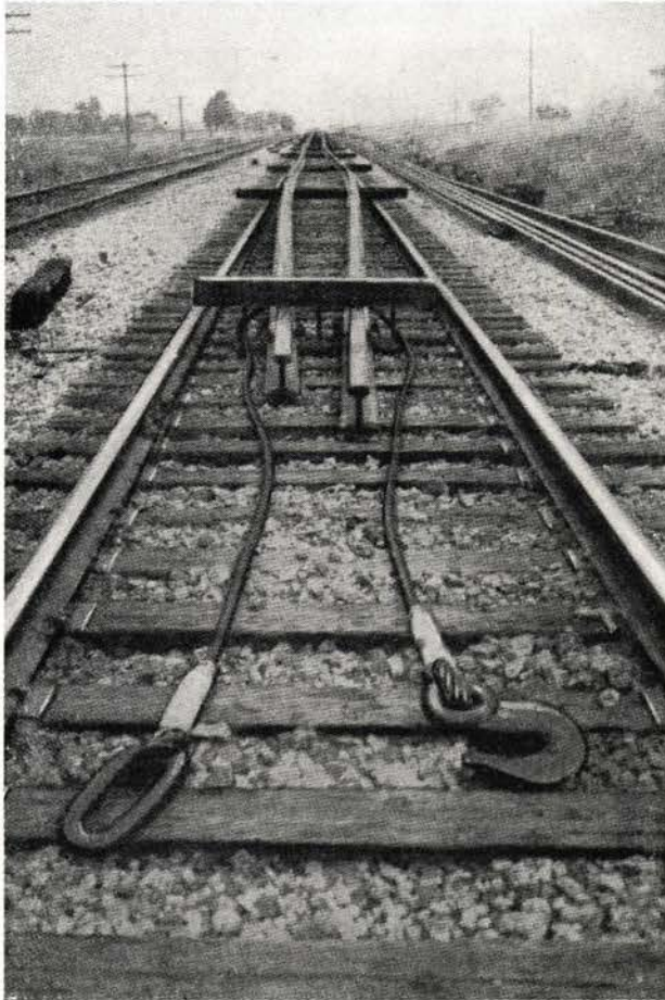
Fig. 1. To langskinner lagt på alminnelige tresviller klar til uttrekking ved Elgin, Joliet and Eastern Railway Co.
