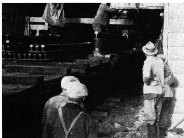
Fig. 3. Firing av skinne ned på skinnerullene.
