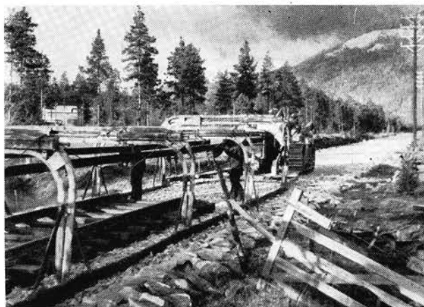
Fig. 15. Løpebjelkene er igjen løftet opp og 2 mann skyver løpekattene tilbake. Bulldozeren trekker så utleggerapparatet 36 meter fram.
