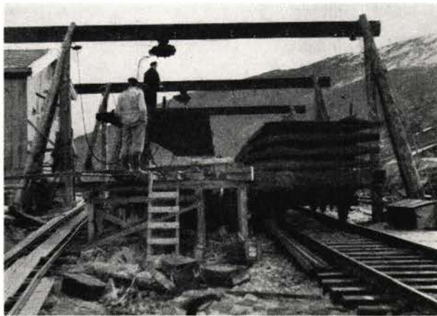
Fig. 5. Lenken er ferdig og heises som den siste opp på kobbelet. Til venstre framføringsspor for skinner fra skinnelageret (1954).
