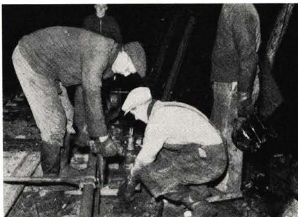
Fig. 3. Boring gjennom ekekloss og sville. Samme maskin som vist på fig. 2. Fleksibel kabel mellom maskin og borhodet.
