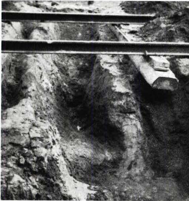
Fig. 3. Foto (1952) av forholdene i fig. 2. Midt på bildet er grusen (fra 1870-årene) fjernet, men ligger igjen under svillene i høyre side av bildet med skarpt skille mot kvabbsgrunnen.
