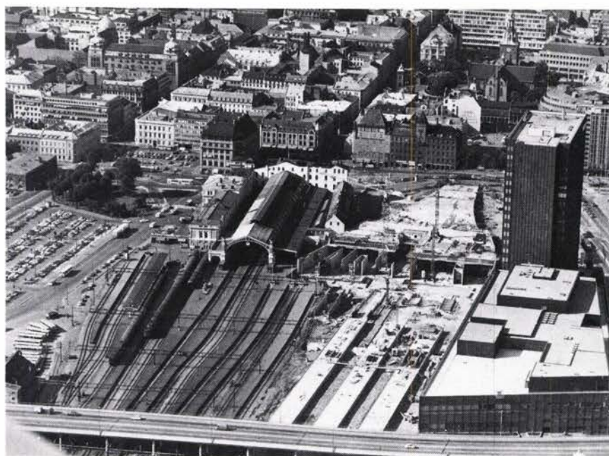
Oslo-tunnelen under bygging inn mot Oslo S (september 1977).
