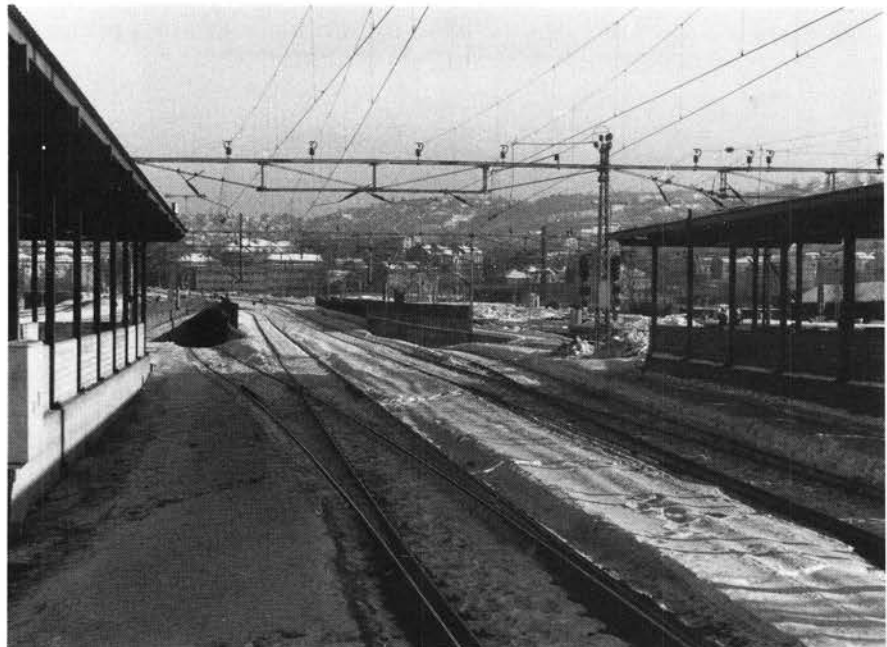
Spor 8 og 9 (sett mot øst) med avvik til forbindelsestunnelen for nærtrafikk til Østfoldbanen. Tracks 8 and 9 (view towards the east) with junctions to the tunnel for local traffic to Østfoldbanen.
