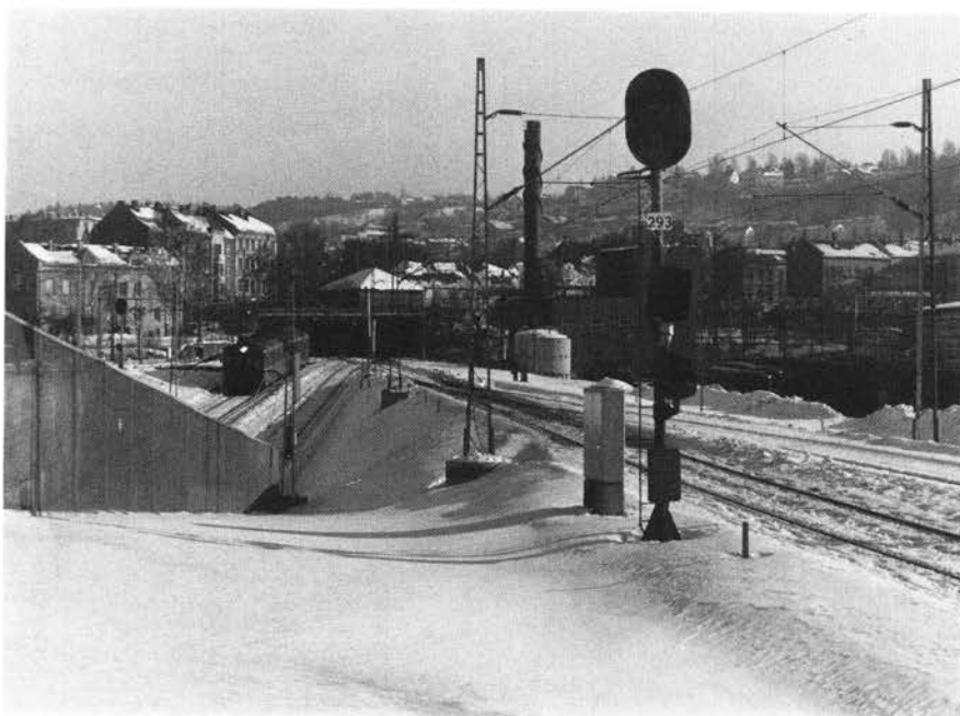
Nedkjøring fra Lodalen til tunnelen under Brynsbakken. Entrance from Lodalen to the tunnel running beneath Brynsbakken.
