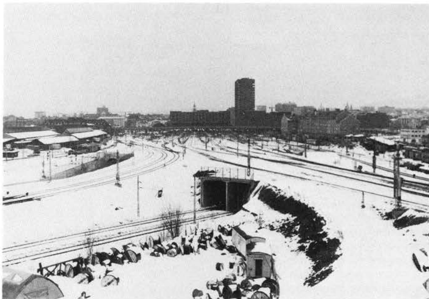
Sporanlegget februar 1987 (sett mot vest), i forgrunnen tunnelen under Brynsbakken, til venstre nedkjøringen til forbindelsestunnelen for Østfoldbanens nærtrafikk.
