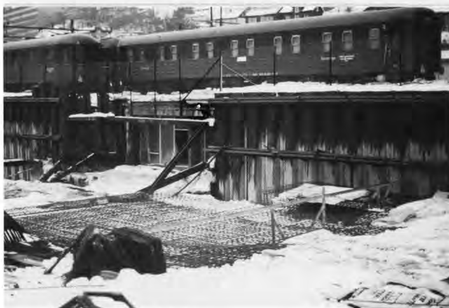
Byggegrøp med innløp til driftstunnelen.
