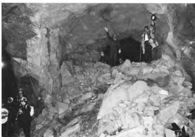
Eeg-Henriksens anleggsleder og tunnelbas er de første over røysa . . .
