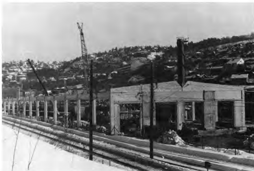
Vognhallens nordre og vestre vegg under oppførelse i mars 1987.
