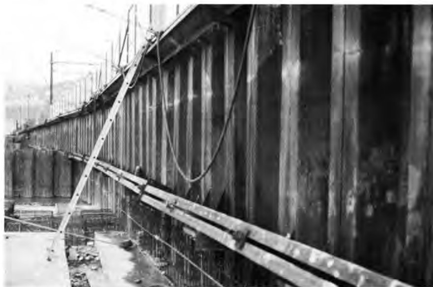
Lange spuntvegger for byggegrop.
