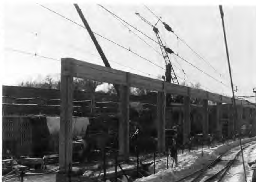
Montering av søyler og dragere i nordre vegg.
