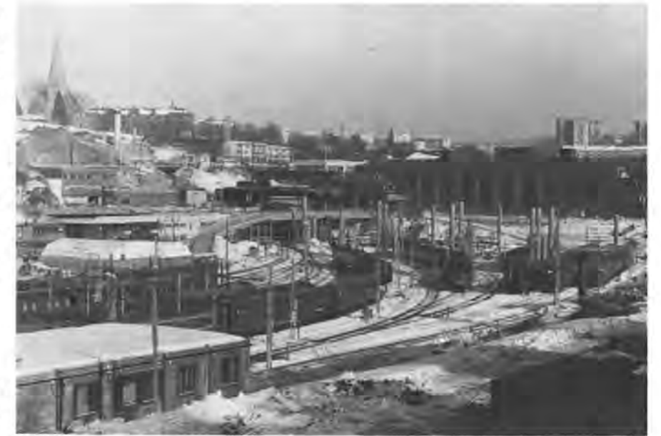
Østre del av Lodalen. I midten innløpet til uttrekkstunnelen under den provisoriske broen for adkomst til byggeområdet. Søylene er for ny bro for riksvei E6, som også er under bygging sammen med veitunnel under Vålerenga.
