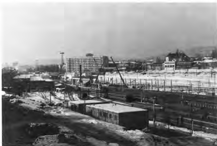
Lodalen sett mot vest. Til venstre Toghallen, til høyre for den skimtes tunnelen til Oslo S og midt i bildet ligger byggeområdet for den nye Vognhallen.
