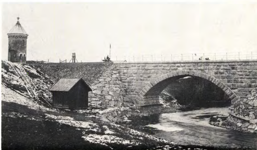
Bro over Fossingelven, Hell-Sunnanbanen – 16 m. Tørmur med udvendig Fugning.
