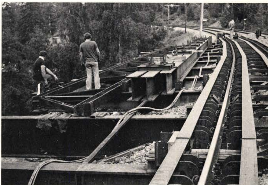
Fig. 1. Sporavstivningssystemet som gjør det mulig å opprettholde toggangen under pressingen.
