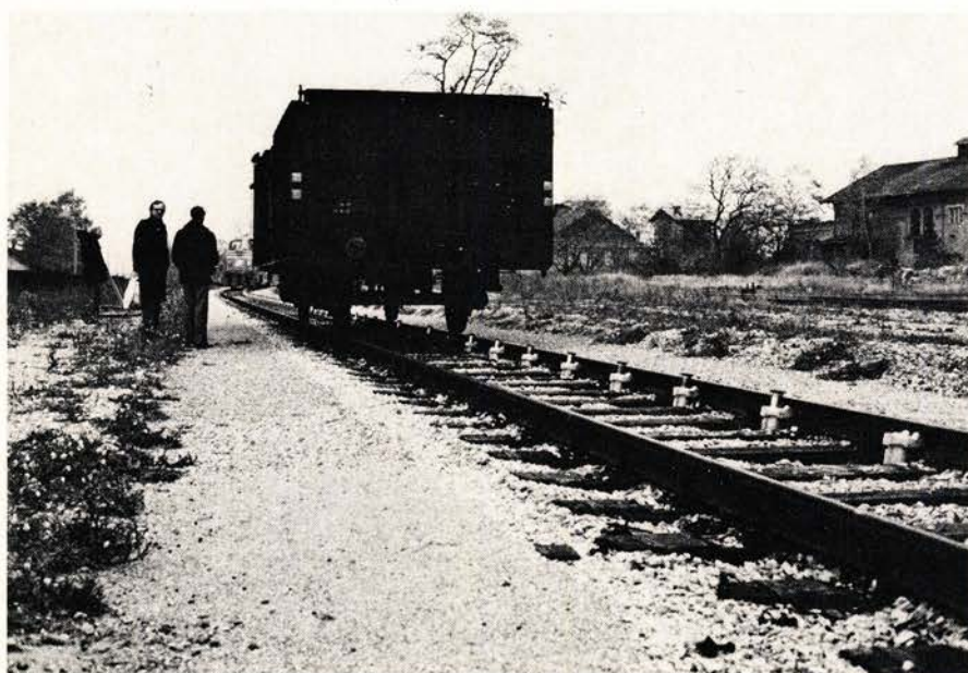
88 Fig. 6. Retningsspor utstyrt med bremsler for kontroll av konstant vognhastighet.
