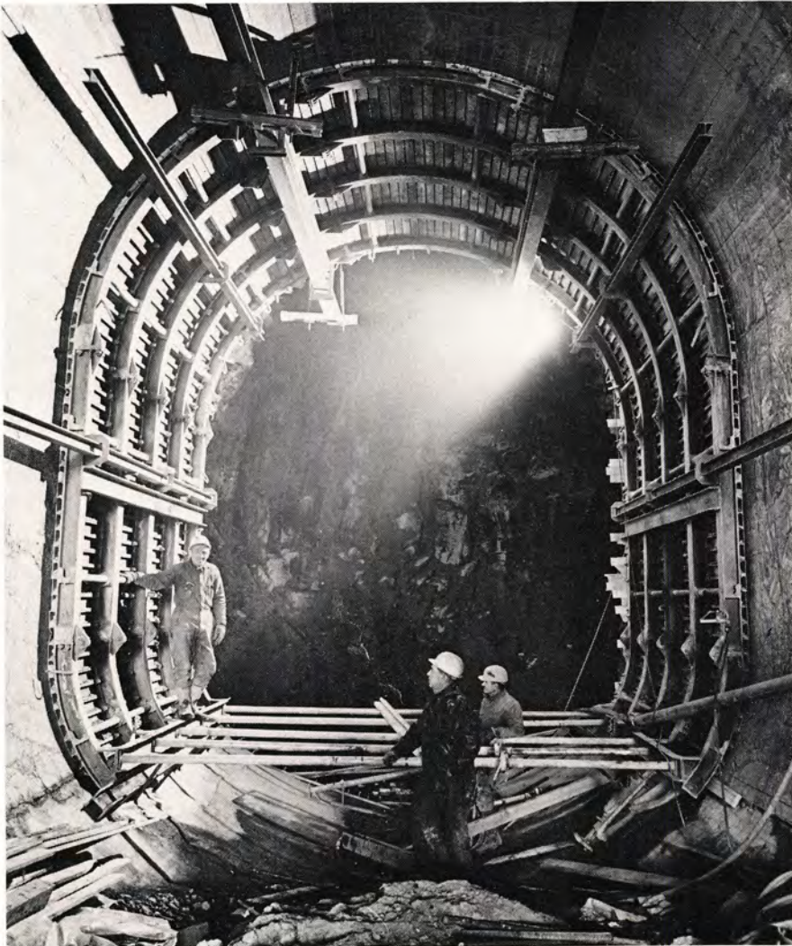
Fig. 33. Forskaling av enkeltsporet tunnel vest for Studenterlunden. Utstøpning nær opptil stoff på grunn av dårlig fjell og liten overdekning.
