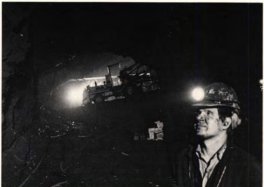
Fig. 24. Fra tunneldriften i alunskifer. Alun er svart som kull og svovelholdig. Sulfatresistent betong ble benyttet ved utstøpningen. Tunneling in alum shale. The shale is black as coal and sulphuric. Sulphate resistant cement was employed for the concrete lining.
