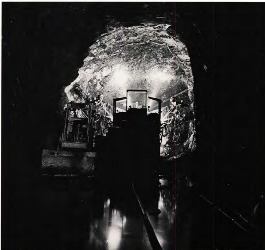
Fig. 14. Fra sprengingsarbeidene i fjelltunnelen 30 m under Frognerområdet. The tunnel face 30 m beneath the surface in the Frogner area.
