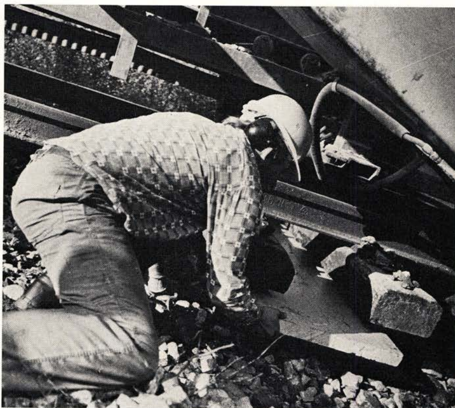
Fig. 2. Innlegging av skumplastplater for teleisolasjon. På pukkbalasterte strekninger utføres arbeidet ved hjelp av ballastrensemaskin, idet maskinen graver vekk pukken i tilstrek-
