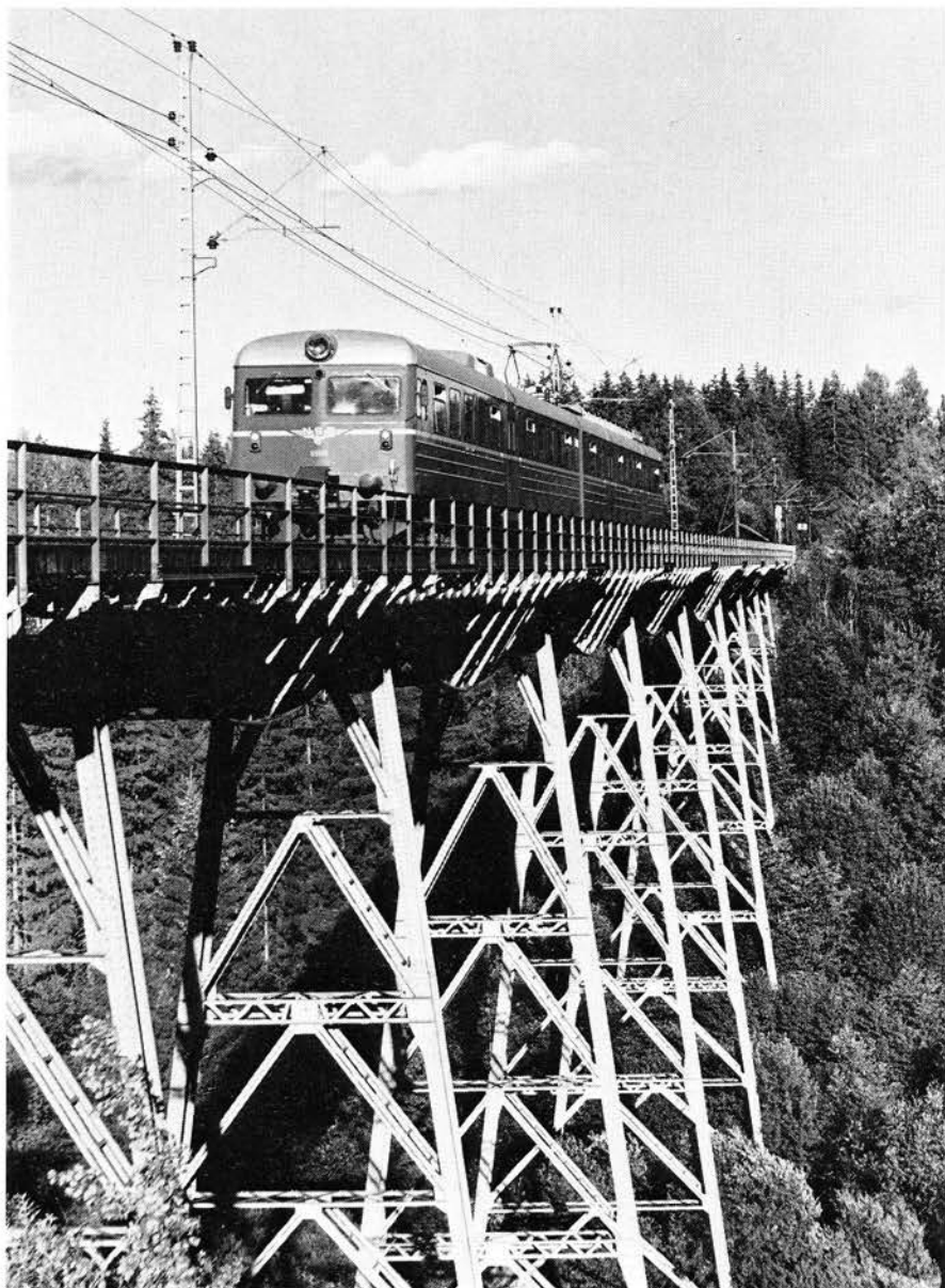
Fig. 1. NSB's korrosjonsproblemer i et nøtteskall.
