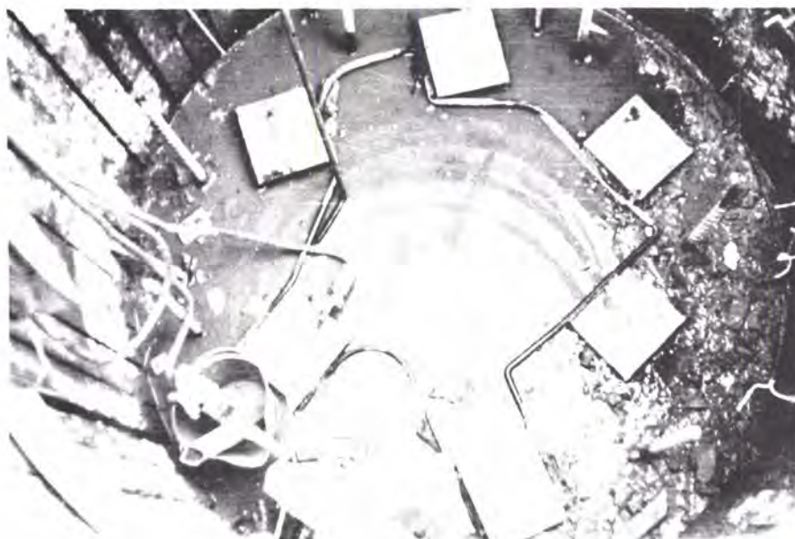
Fig. nr. 19 viser byggegropa med stålpeler sammenkoblet for katodisk beskyttelse.
