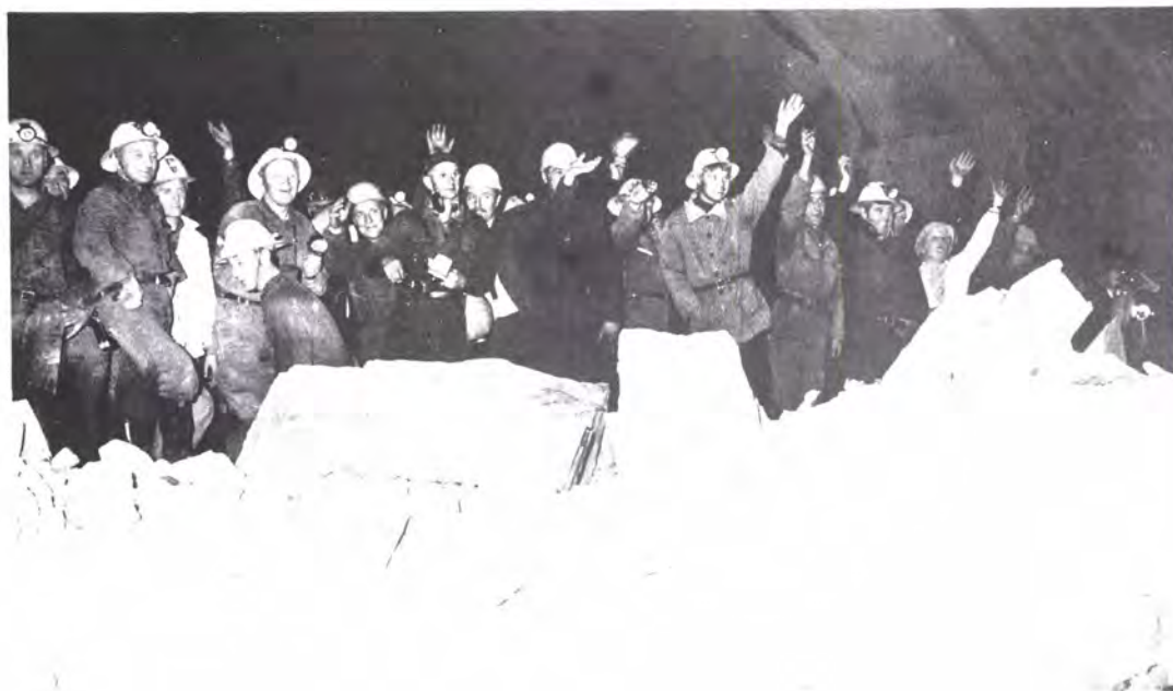
Fig. nr. 54 viser noe av stufflaget på røysa etter siste salve.
