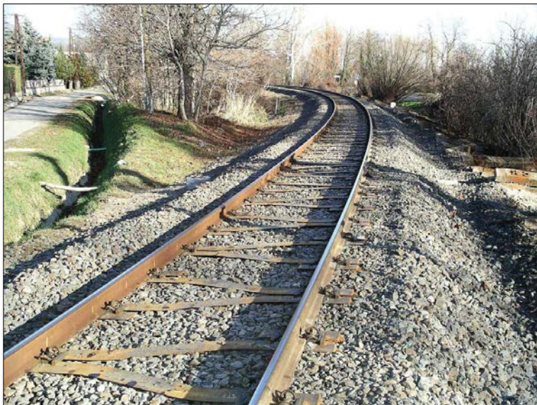
Figur 13. Spor med Y formet stålsviller, (Liegnér, 2004)
