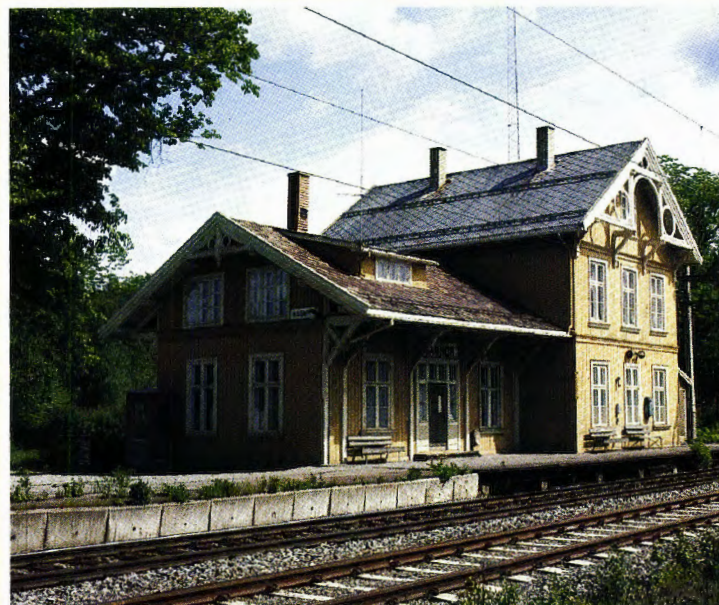
Magnor stasjonsbygning på Kongsvingerbanen. Byggeår: 1865. Arkitekt: Georg Andreas Bull. (Foto i 1993: Jan Erik Hellerud.)
