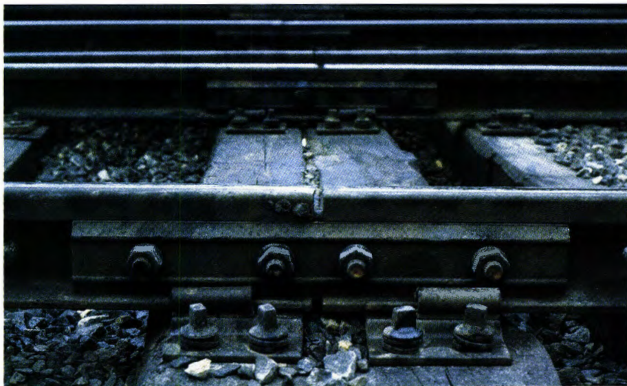
Ka-tong, ka-tong! Når toghjulene passerte over slike skinneskjøter, oppsto den typiske jernbanelyden – eller også – låten, siden vi finner den igjen i mye musikk. De to skinnestykkene ble holdt sammen med et skjøtestykke – en såkalt lask. (Foto: Hans-Petter Lyshaug.)
