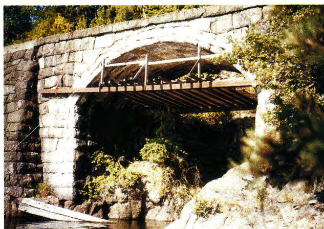
En av de eldste trebroene, Selsbak viadukt på Trondheim–Størenbanen. Den ble bygd i 1864 og hadde 29 spenn med spennvidder fra 5,5 til 6,6 m. Total lengden er 180 m. (Foto i 1864: Carl Abraham Pihl.)
