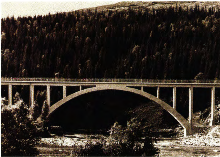
Broen over Holmvasselv på Nordlandsbanen er bygd som en buebro med spennvidde 48 m, den har dessuten fem mindre sidespenn, slik at total bro lengde er 96 m. Utført i 1938. (Foto: Normann.)
