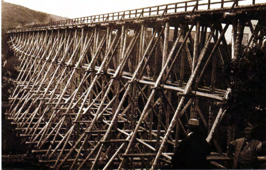
En av de eldste trebroene, Selsbak viadukt på Trondheim–Størenbanen. Den ble bygd i 1864 og hadde 29 spenn med spennvidder fra 5,5 til 6,6 m. Total lengden er 180 m. (Foto i 1864: Carl Abraham Pihl.)
