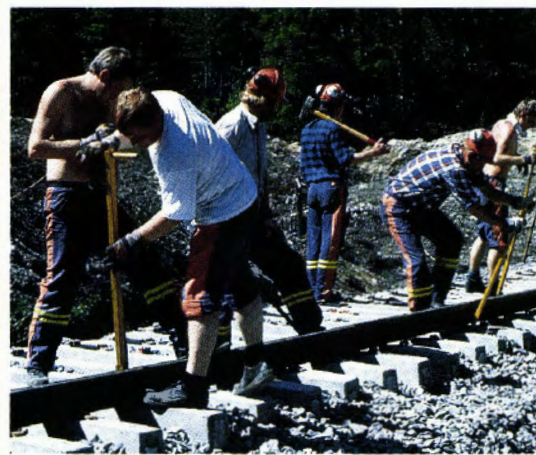
Arbeid på sporanlegg med betongsviller. (Foto i 1992: Anders Haakonsen.)
