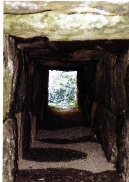
Over: Steinsatt vannrenne under sporet i Drangsdalen mellom Kristiansand og Egersund. (Foto: Bjørn Kummeneje.)
