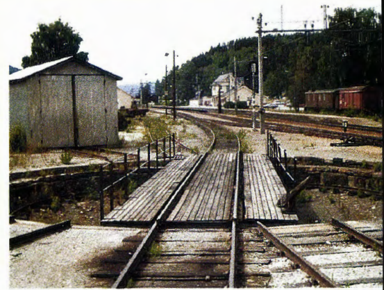
En forholdsvis liten svingskive på Ringebu stasjon. (Foto i 1994: Tor Nilssen.)
