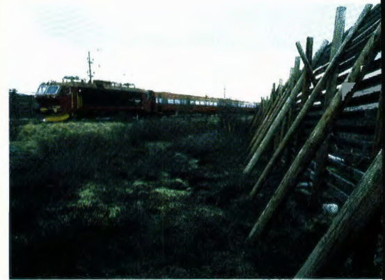
Snøskjerm langs linjen over Dovrefjell. (Foto i 1982: Terje Engh.)
