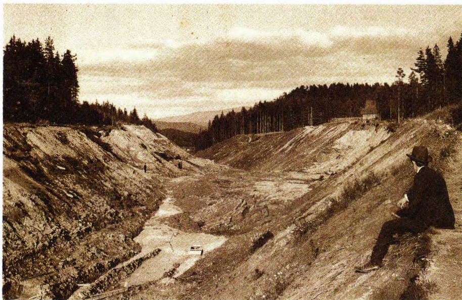
Under: Storskjæringa ved Hønefoss under bygging. (Foto i 1909: NSB/ Jernbaneverket region Sør.)
