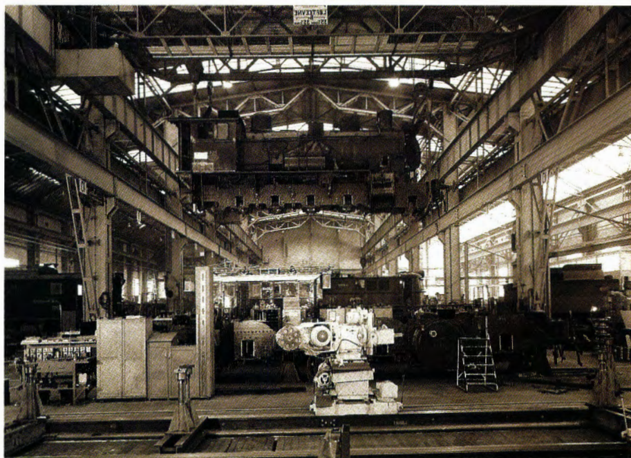
Grorud Verksted har en sentral rolle i NSB. På dette bildet ser vi både damplokomotiv og elektriske lokomotiver. Damplokomotivet henger i en traverskran. (Foto fra 1950-tallet?: Wilse.)
