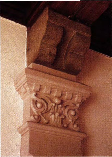
Detalj fra venterommet på Kornsjø stasjon. (Foto: NSB Arkitektkontoret.)
