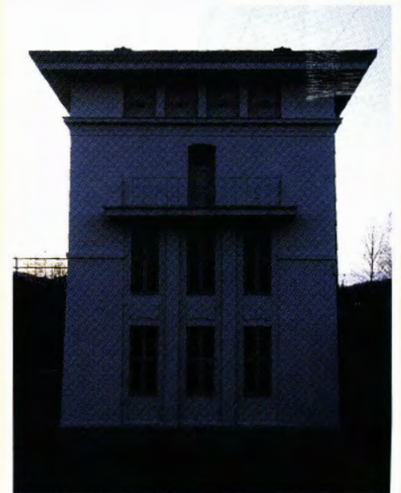
Dette bygget i nyklassisistisk stil finner du ved Skollenborg på Sørlandsbanen. Det er faktisk en transformator. (Foto i 1993: Øistein Mangset.)
