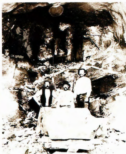
Fra arbeidet i Gravhals-tunnelen. (Foto: Norsk Jernbanemuseum.)
