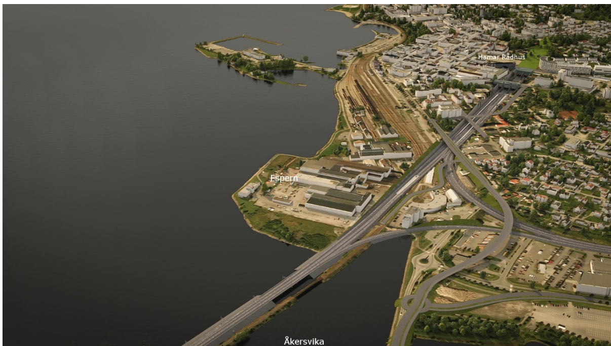
Figur 69 Hamar stasjon, sett fra syd, Korridor2
