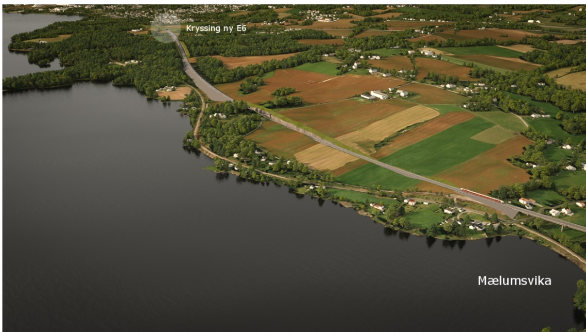
Figur 106 Fra Mælumsvika til kryssing under planlagt, ny E6
