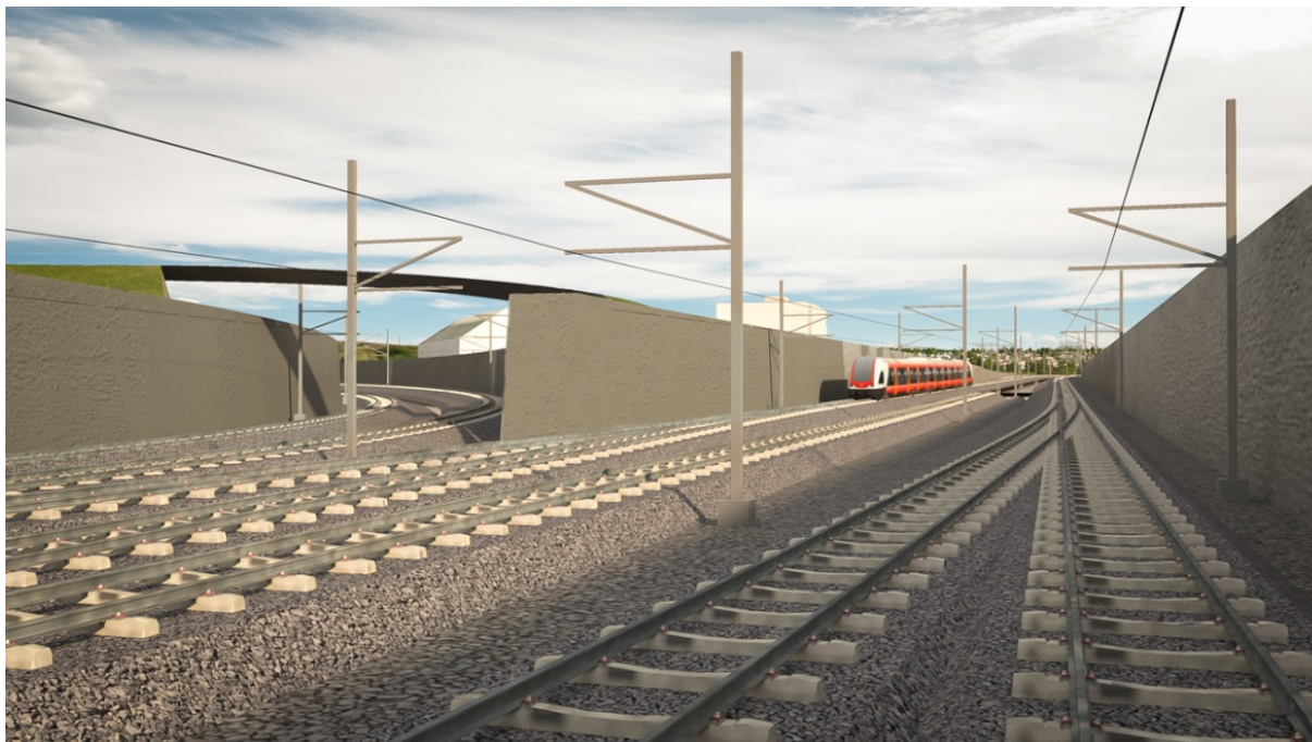
Figur 83 Trauets vegger fungerer som flomvern. Sett fra spor mot sydvest i Espern-området.
