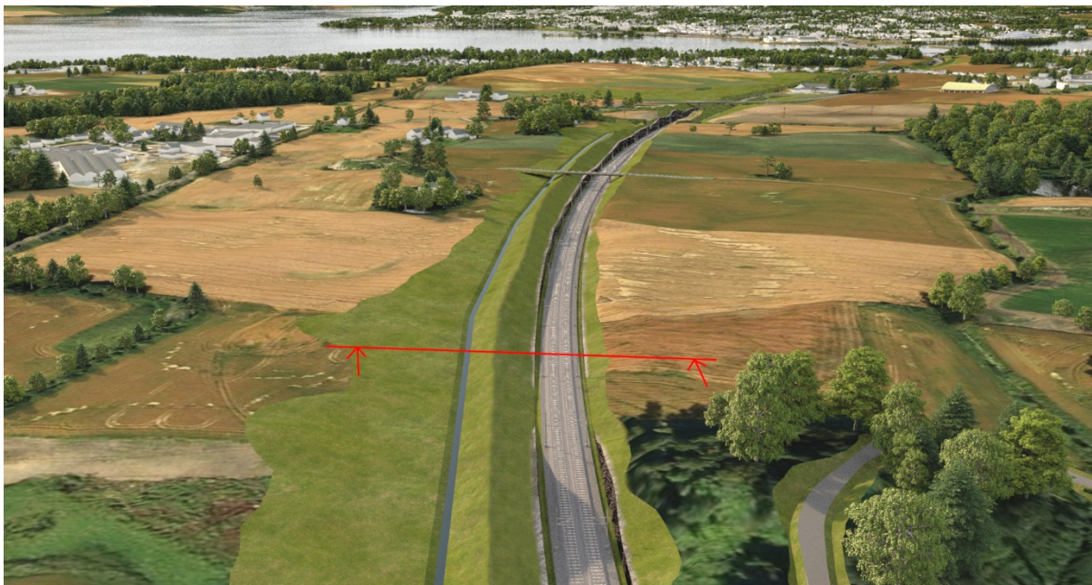
Figur 20 Utklipp bilde viser markering ved snitt km 121,000
