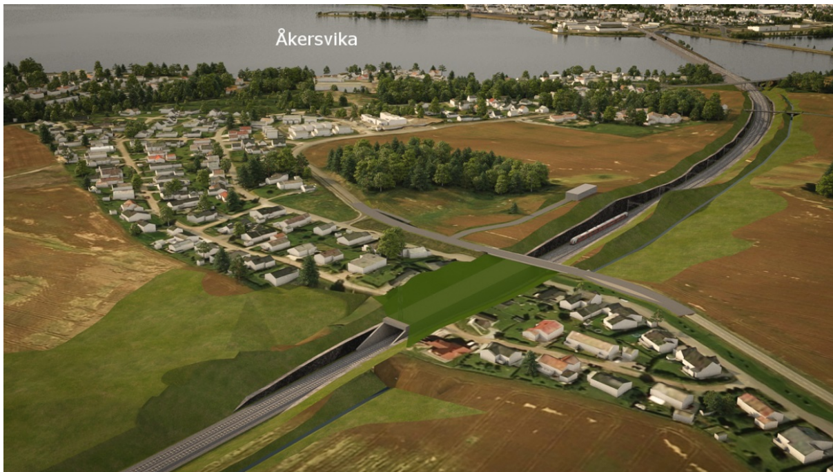
Figur 67 Bekkelaget, kulvert, Korridor 2
