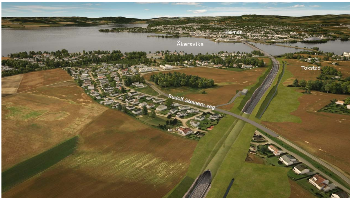
Figur 120 Gjennom Bekkelaget med 2 spor gjennom en 125 m lang kulvert, 56-1a østre variant. Breddeutvidelse til 3 spor like nord for kulvert
