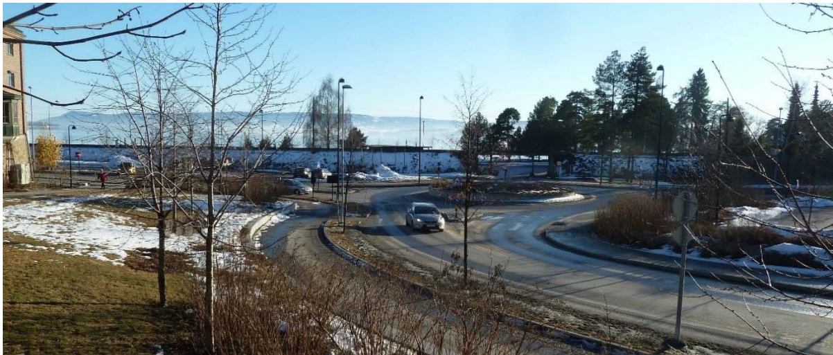
Figur 145 Foto fra dagens situasjon i Aslak Bolts gate, sett sørover mot Mjøsa. Jernbanen ligger som en barriere, men er hevet såpass høyt at det er etablert en naturlig forbindelse ut til Koigen.
