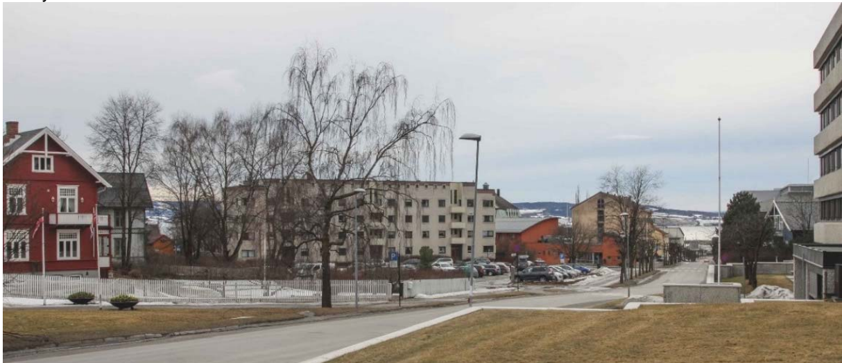
Figur 199. Foto av eksisterende situasjon. Tatt utenfor Statens vegvesen sine lokaler i Parkgata.
