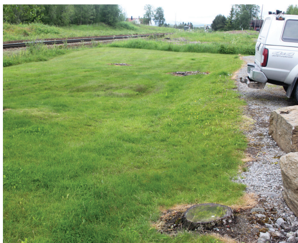
Figur 35 Sparbu stasjon, Nordlandsbanen. Mangelen på en avgrensning, resulterer i at bilene parkerer på plenarealet. Plenen får slitasjeskader, og grusen glir utover.
