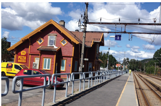
Figur 9 Vennesla stasjon, Sørlandsbanen. Stasjonen imøtekommer Jernbaneverkets basisstandard
