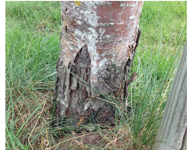
Figur 18 Jaren stasjon, Gjøvikbanen. Treet har blitt utsatt for mekaniske skader på stammen.
