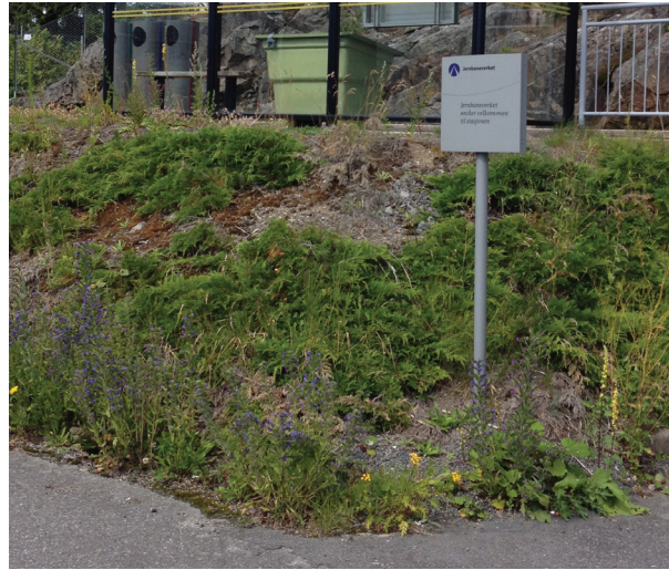
Figur 28 Stoa holdeplass, Sørlandsbanen. På stasjonen er det plantet vintergrønne bunndekkerne. Vegetasjonen fungerer dårlig, da regnvann renner ned bakken, jorda inneholder mye grus og stein, og mye ugress vokser til.
