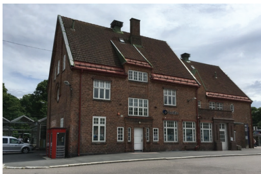
Figur 10 Tønsberg stasjon, Vestfoldbanen Stasjonen imøtekommer Jernbaneverkets tileggsstandard
