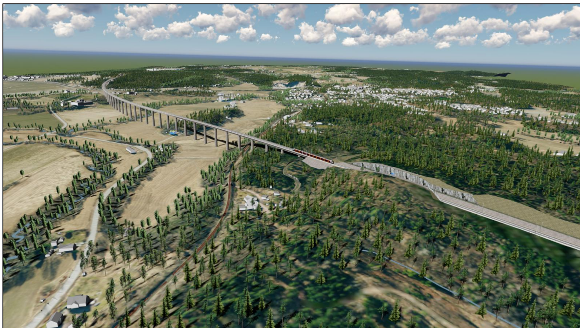
Figur 5-30: Viadukt sett mot sør
