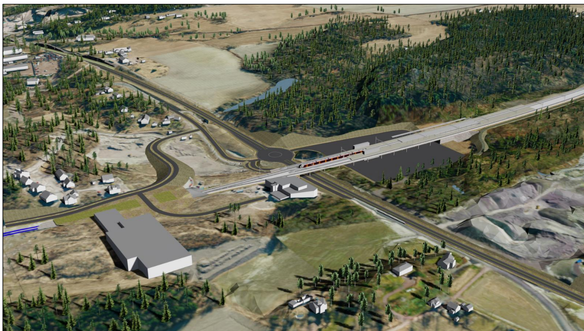
Figur 5-49: Stasjon på Skoppum vest sett mot øst
