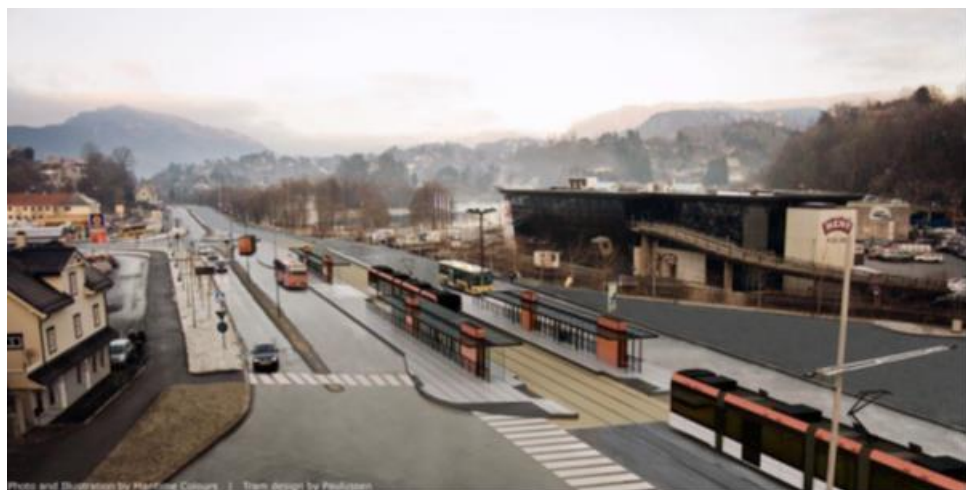
Figur 8.3: Eksempel på kollektivknutepunkt: Nesttun Bergen 7
