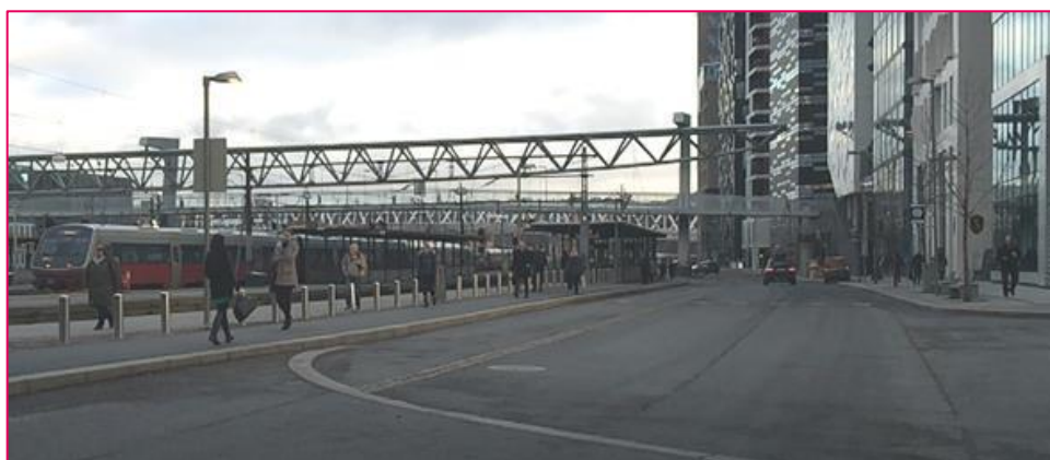
Figur 6.1: Situasjonsbilde fra Spor 19 på Oslo S
