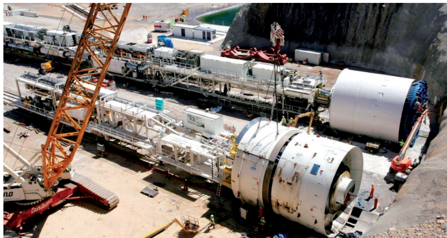
Montering av tunnelboremaskiner (TBM). Follobanen skal ha fire maskiner som alle har en diameter på ca. 10 meter og en lengde på ca. 100 meter. Foto: Acciona Ghella JV.
