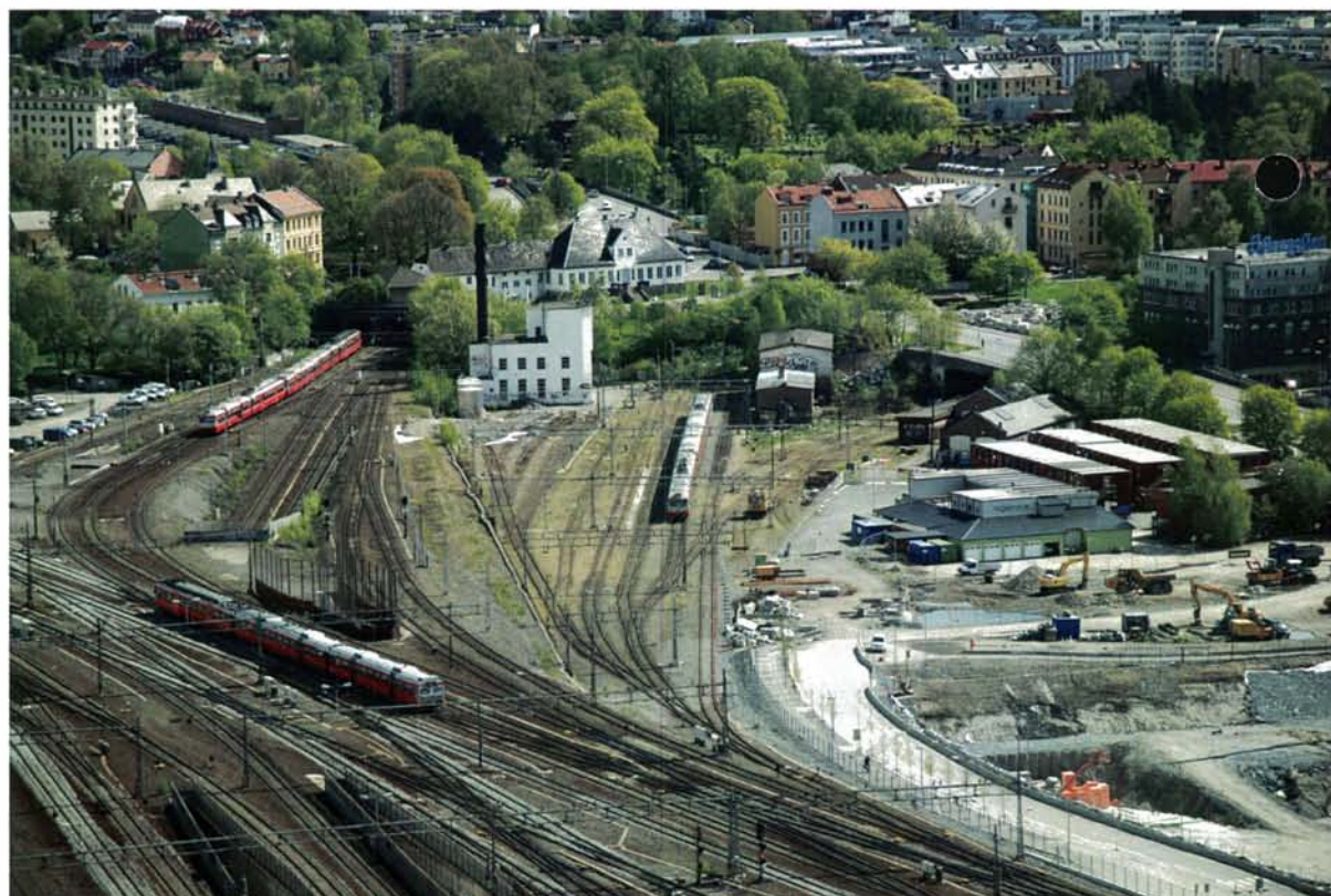
I dette travle og kompliserte området skal de to nye sporene fra Follobanen bygges i fremtiden. Foto: Jernbaneverket/ Trude Isaksen.
