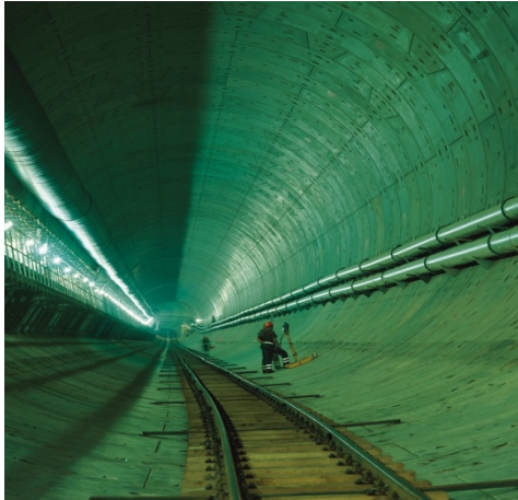
Figur 22. Fullprofilboret tunnel linet med betongsegmenter. Foto fra Herrenknecht AG.
