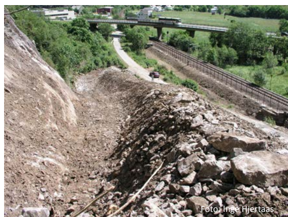
Figur 2.25 Skredsikring ved Dalegarden
