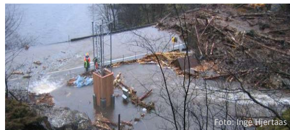
Figur 2.15 I 2005 ramma raset både veg og bane. Banen ligg under vatn i nedre del av biletet.
