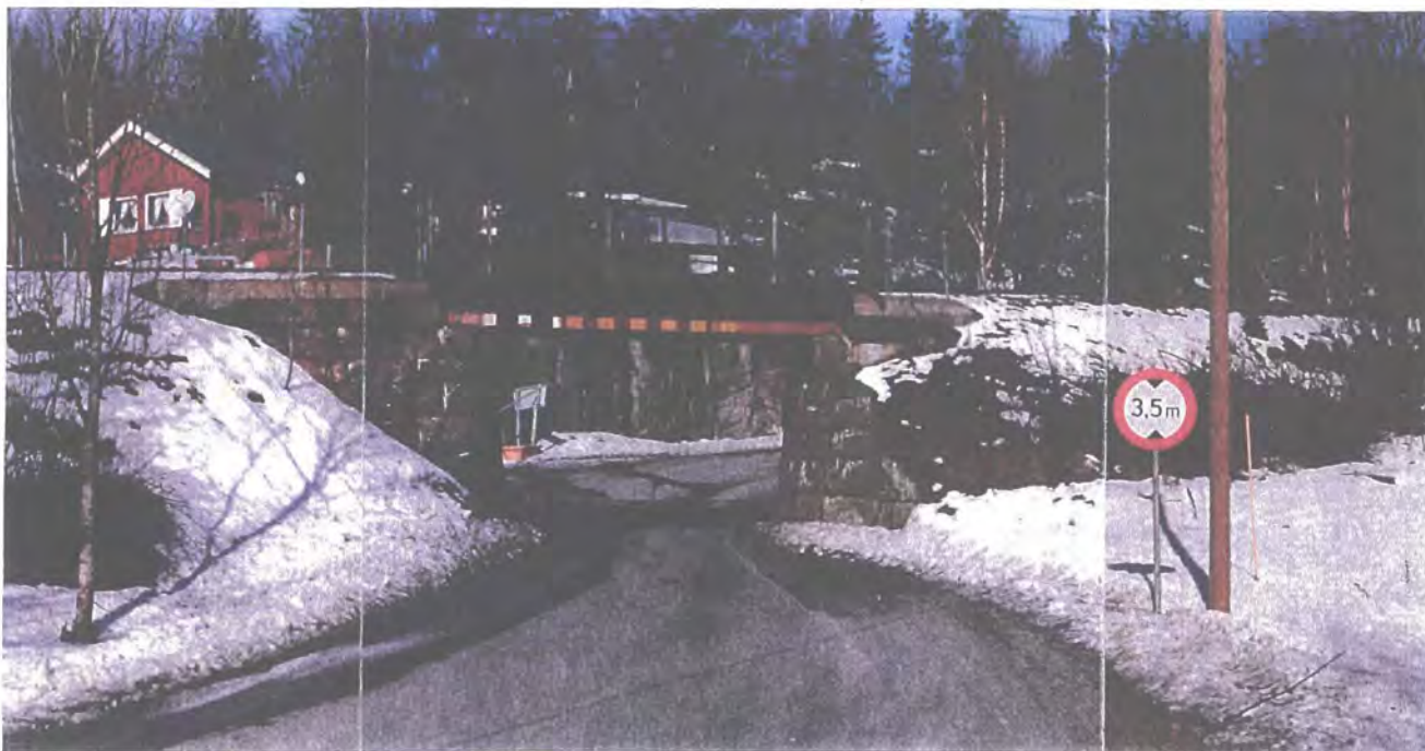
Fv 670 svinger fortsatt under en av de gamle, gråsteinsmurte undergangene
