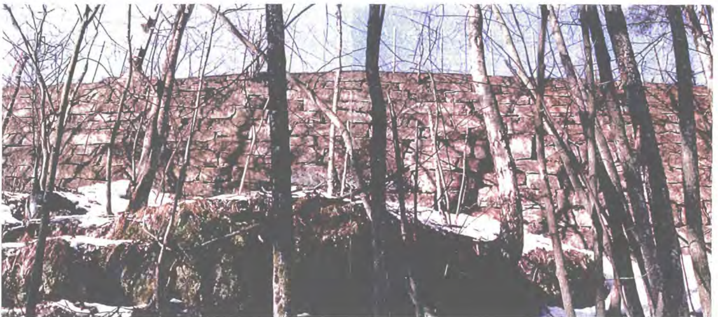
Ved Rygland går Vestfoldbanen høyt i åssiden, på murer av fint lagt naturstein.
