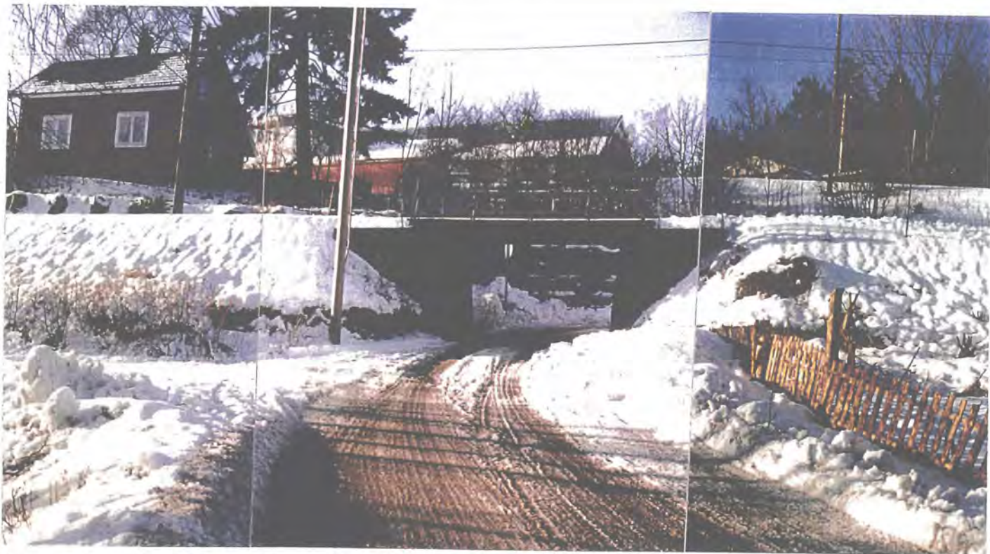
Hortensporet og Vestfoldbanen ligger i ulike nivåer i det bratte terrenget mot Skoppum stasjon. Bildet er tatt fra Ryglandsveien mot undergangen for Hortensporet. Banevokterboligen til Vestfoldbanen ses til venstre, en av undergangene til Vestfoldbanen lenger inn. Borreborg ses mot horisonten øverst til høyre.
