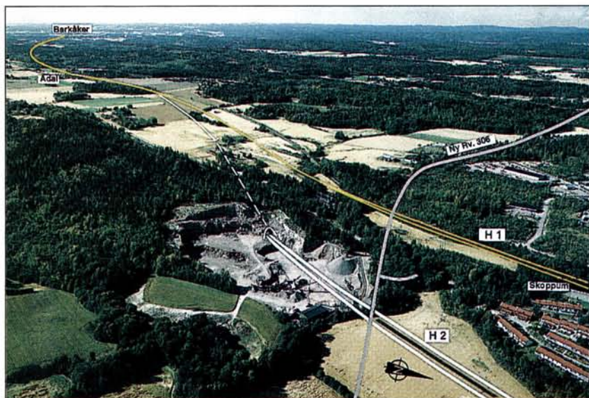
Figur 28: Alternativ H1 og H2 gjennom Skoppum, sett sørvestover. Steinbruddet midt i bildet er aktuelt for masseuttak og massedeponi.
