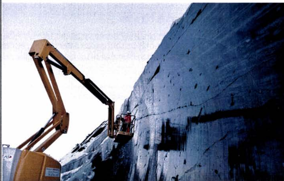
Wiresaging. Ved Engervannet skal om lag 70 000 kubikkmeter fjell sages bort. Foto: Hilde Lillejord.
