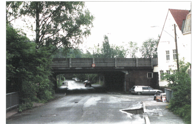
Fig. 8.2.8 Jernbanebru over Bestumveien og tidligere Bestum stasjon.
