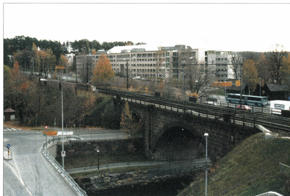
Fig. 8.3.2 Jernbanebrua over Lysakerelva er bygget i hogd naturstein og er her sett fra nordsiden.
