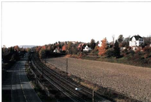
Fig. 8.6.5 Verneverdig bebyggelse ved Terrasseveien. Alt H1B går i kulvert diagonalt over jordet.
