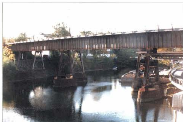
Fig. 8.8.6 Nåværende jernbanebruer over Sandvikselva sett fra øst.
