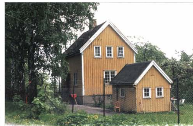
Fig. 8.5.4 Banevokterbolig i Marstranderveien blir berørt av Alt. H1B og H2B.
