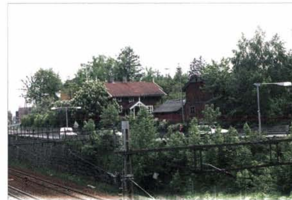
Fig. 8.3.5 Vollsveien 8 må rives eller flyttes p.g.a. omlegging av Vollsveien..
