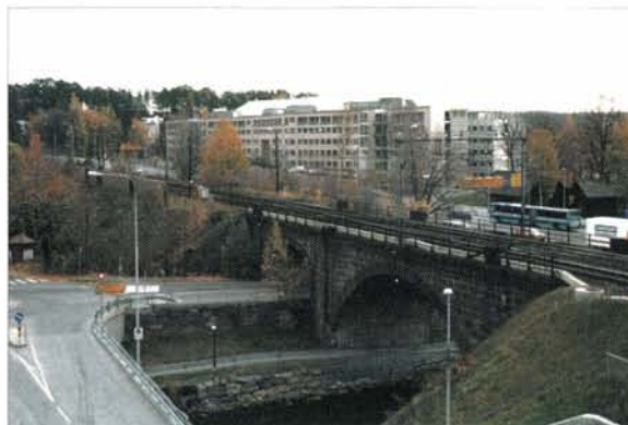
Fig. 8.3.2 Jernbanebrua over Lysakerelva er bygget i hogd naturstein og er her sett fra nordsiden.
