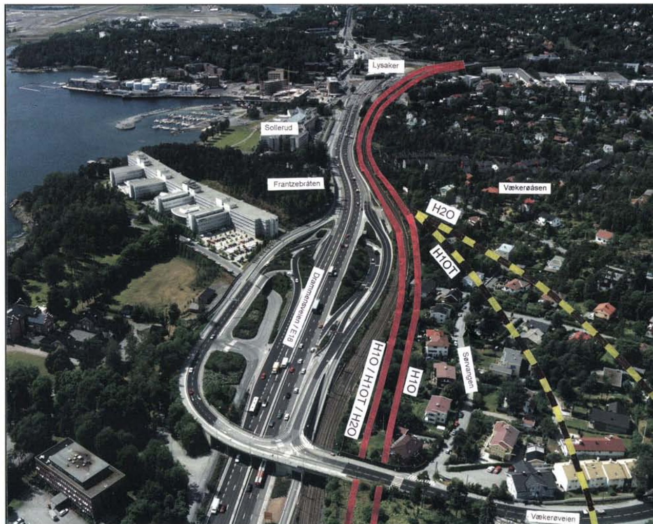
Fig. 8.2.1 Vækerøområdet sett mot Lysaker. Røde linjer er alternativ H10 og rød linje nærmest E18 er dessuten østgående spor for alt. H10T og H20. Gul linje er alternativ H20 vestgående spor. (Fotonor AS)
