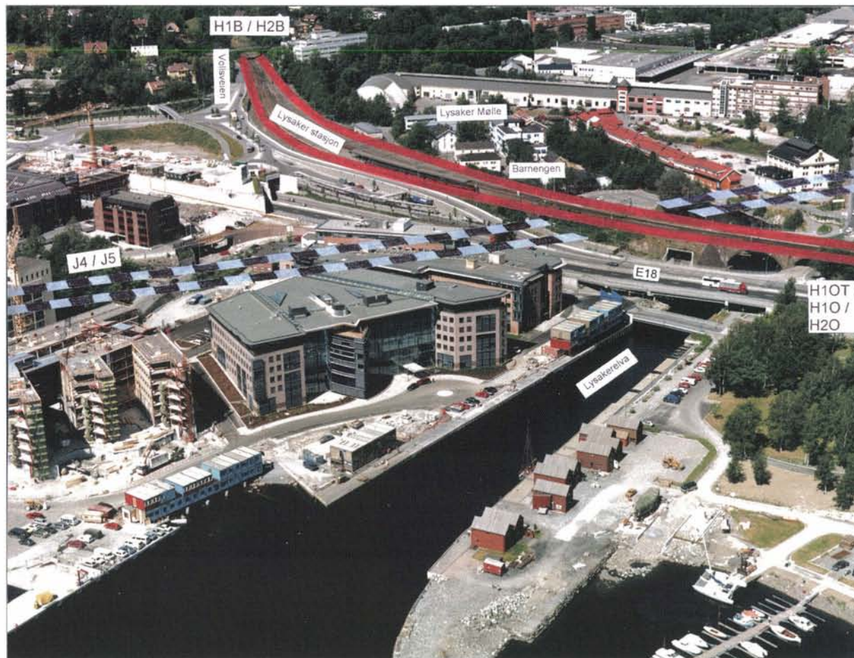
Fig. 8.3.1 Lysaker stasjonsområde sett fra sørøst. Røde linjer er nytt dobbeltspor og lokaltogspor for alternativene H10, H10T og H20 med stasjon i dagen. Blå linjer er nytt dobbeltspor og lokaltogspor for alternativene J4/J5 med stasjon under bakken. (Fotonor AS)
