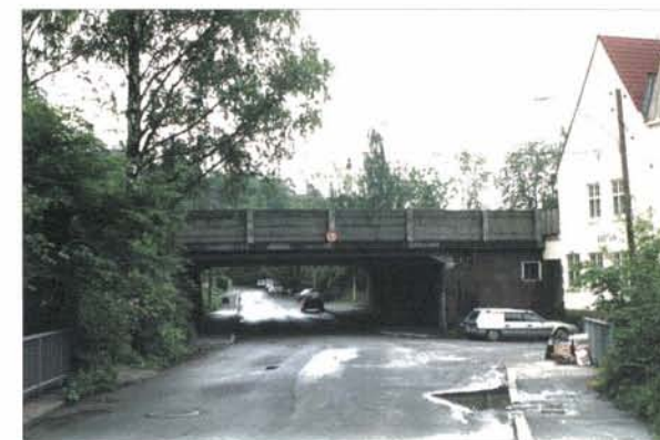
Fig. 8.2.8 Jernbanebru over Bestumveien og tidligere Bestum stasjon.
