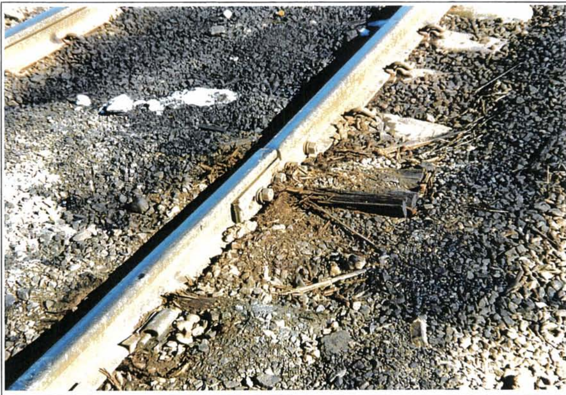
Bilde 2: Bildet viser sporkvaliteten på skiftespor inn mot lokstallen.
