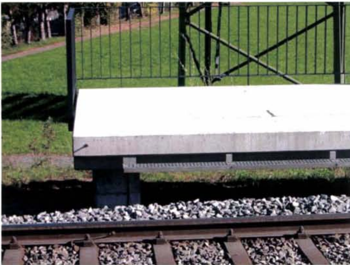
Enkel konstruksjon med betongelementer for bygging av plattformene.
