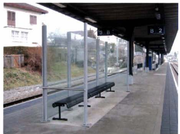
Vindbeskyttelse av glass med sittebenker
