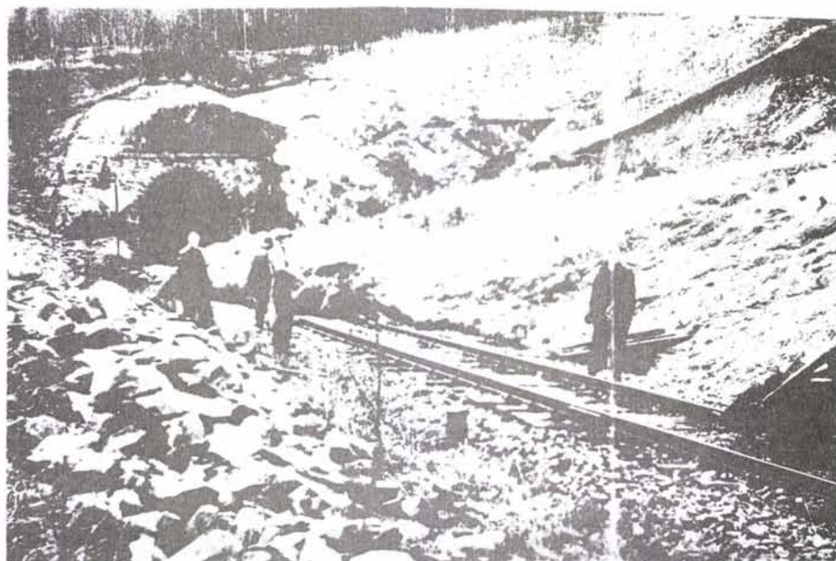
Bergsnev tunnel syd, km 421.
