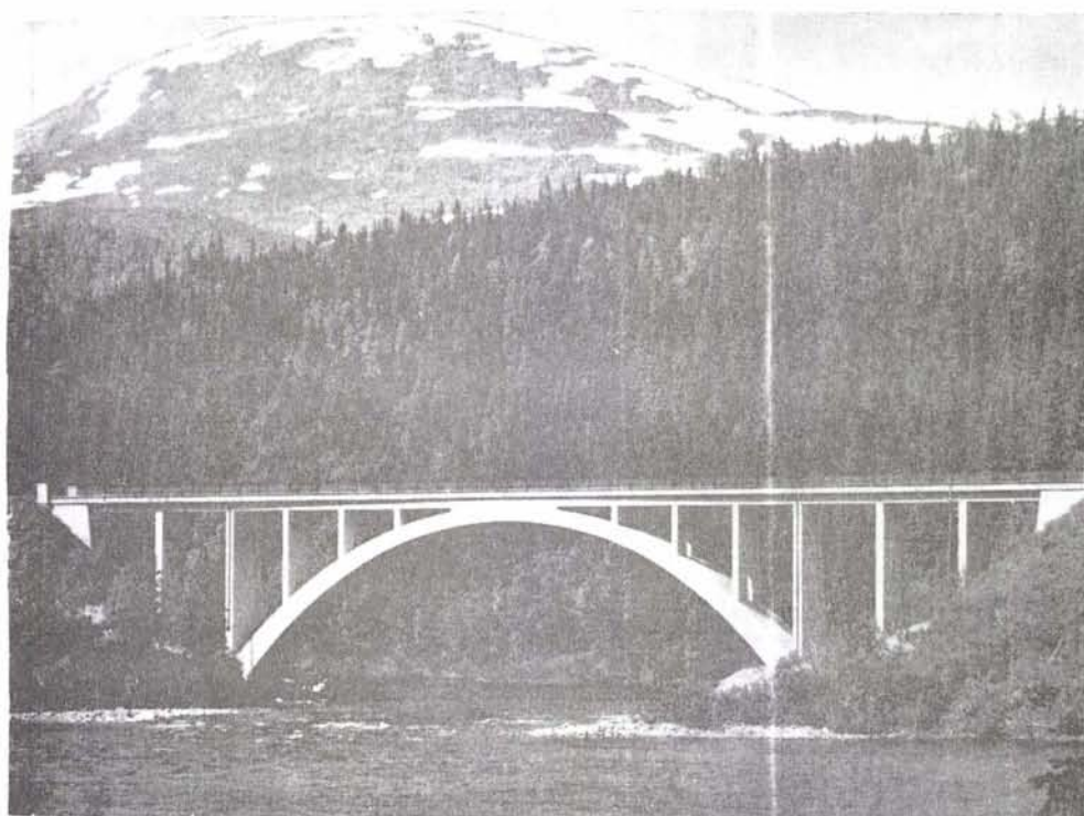
Bru over Holmvasselva.
