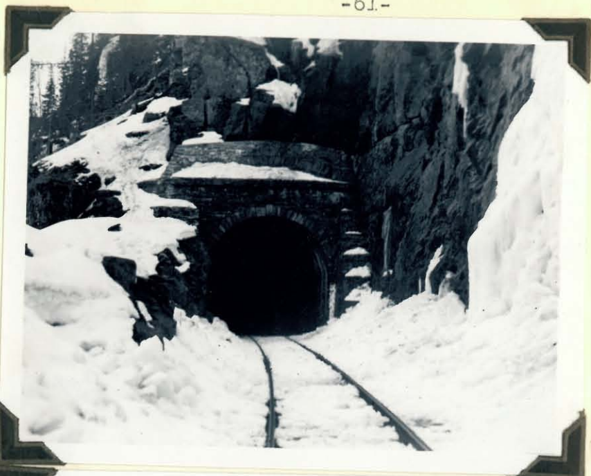
Tunnel ved Sunnan
