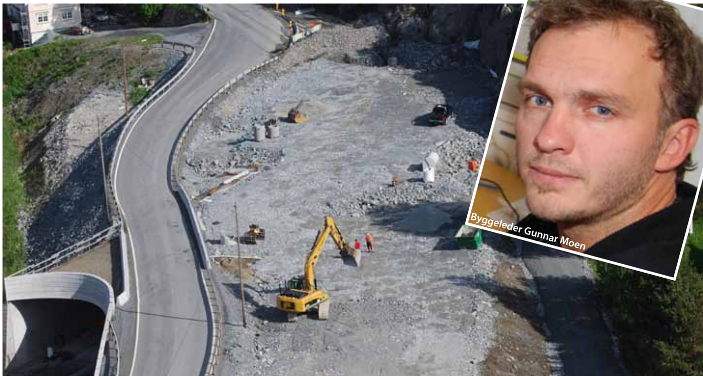
SKAL VEKK: Anleggsveien på Hell blir en saga blott i løpet av høsten. (Foto: Stig Herjuaune)
